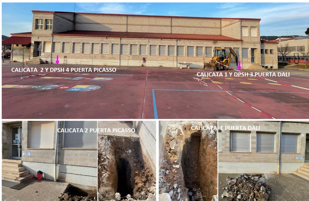
Ubicación de las calicatas y DPSH efectuados el 04/01/2022
