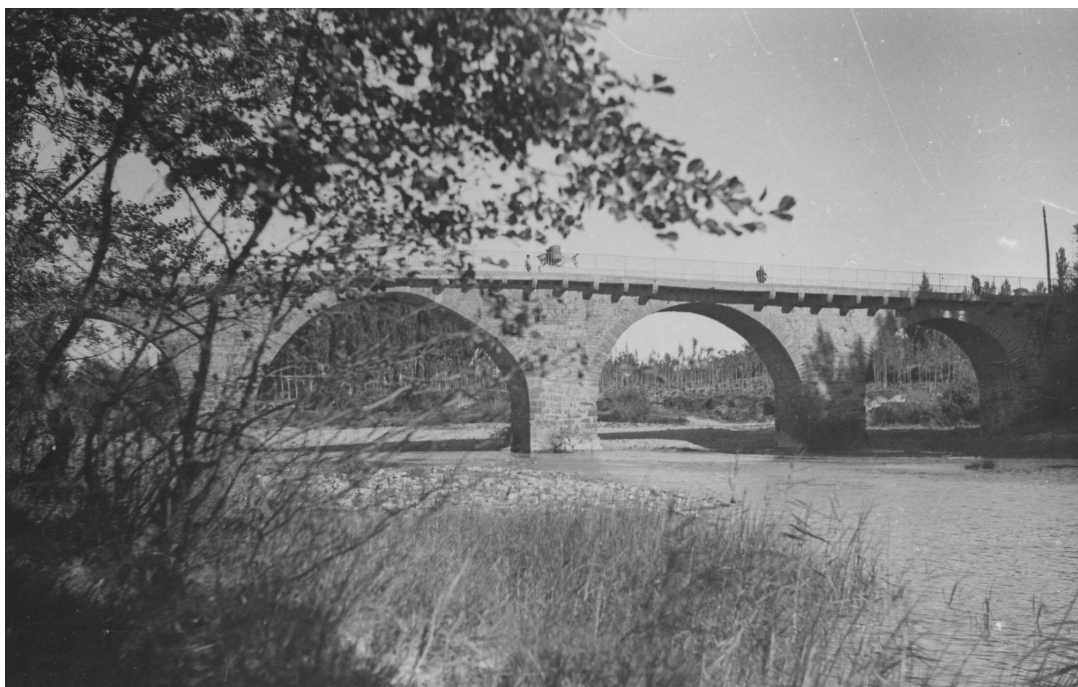
Foto realizada en torno a 1944 de las obras de ampliación (aguas abajo). Fototeca de Navarra
