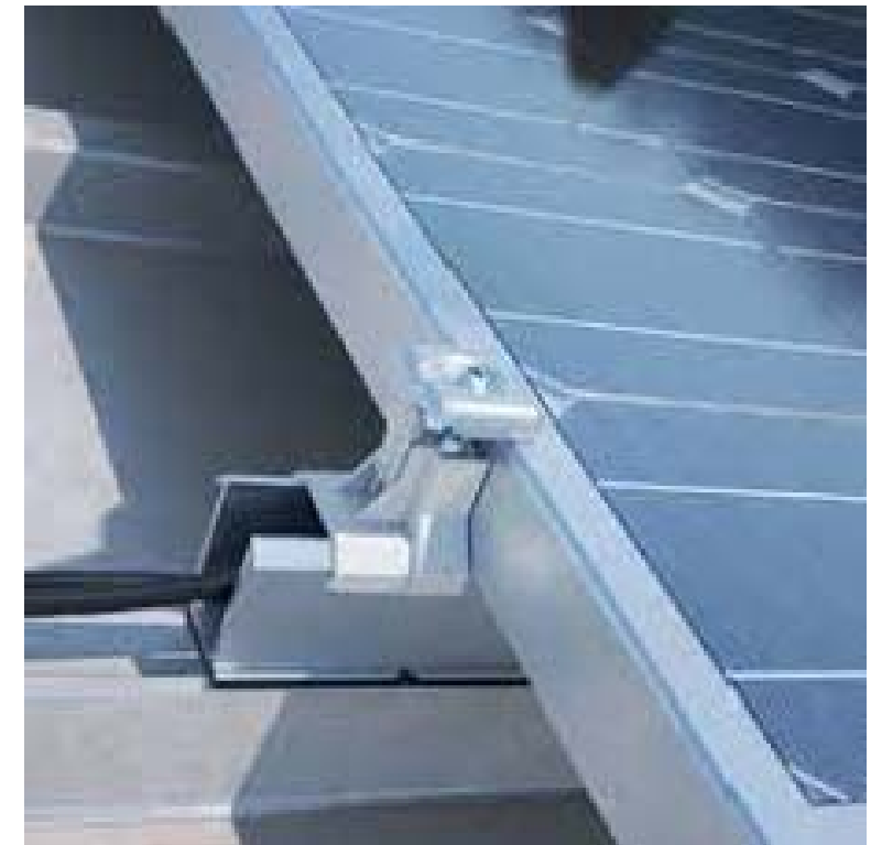
DETALLE SUJECIÓN PANEL CUBIERTA METÁLICA
