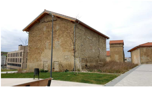
ESTADO ACTUAL. ASPECTO EXTERIOR
