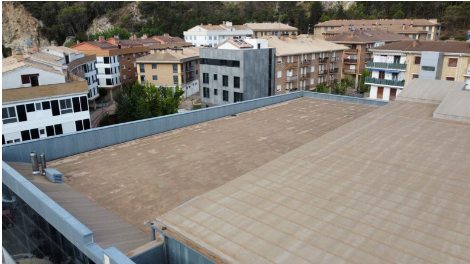
Cubierta sur (zona piscina cubierta)
