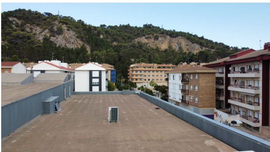
Cubierta norte (zona oficinas)
