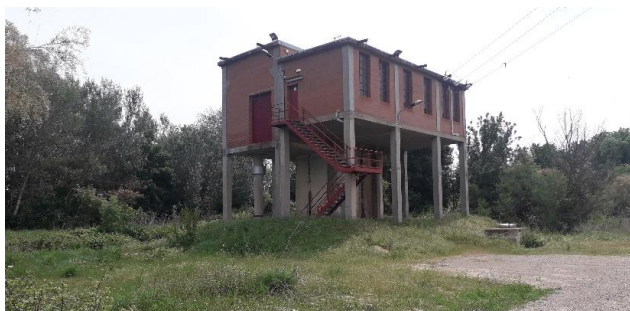
Bombeo del Ebro: Caseta de bombeo
