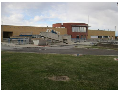
ETAP: Edificio principal
