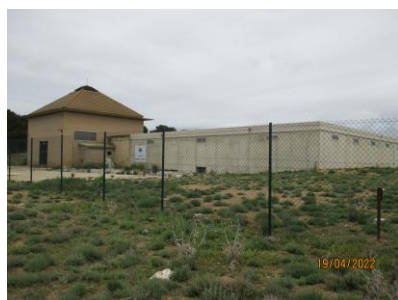
Depósito de Montes de Cierzo: Vista exterior
