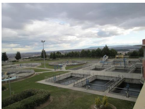
ETAP: Filtros de arena
