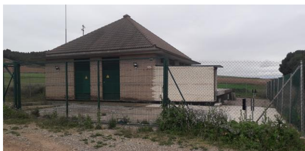
Bombeo de Montes de Cierzo: Caseta de bombeo
