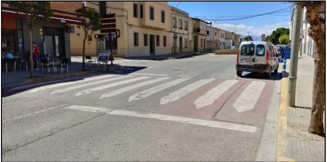
Detalle paso peatones elevado
