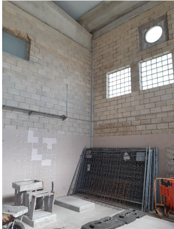
Vista de la sala de desodorización. Al fondo y en la esquina, el pilar medianil con la sala de rejás. En la base, las bancadas existentes.
