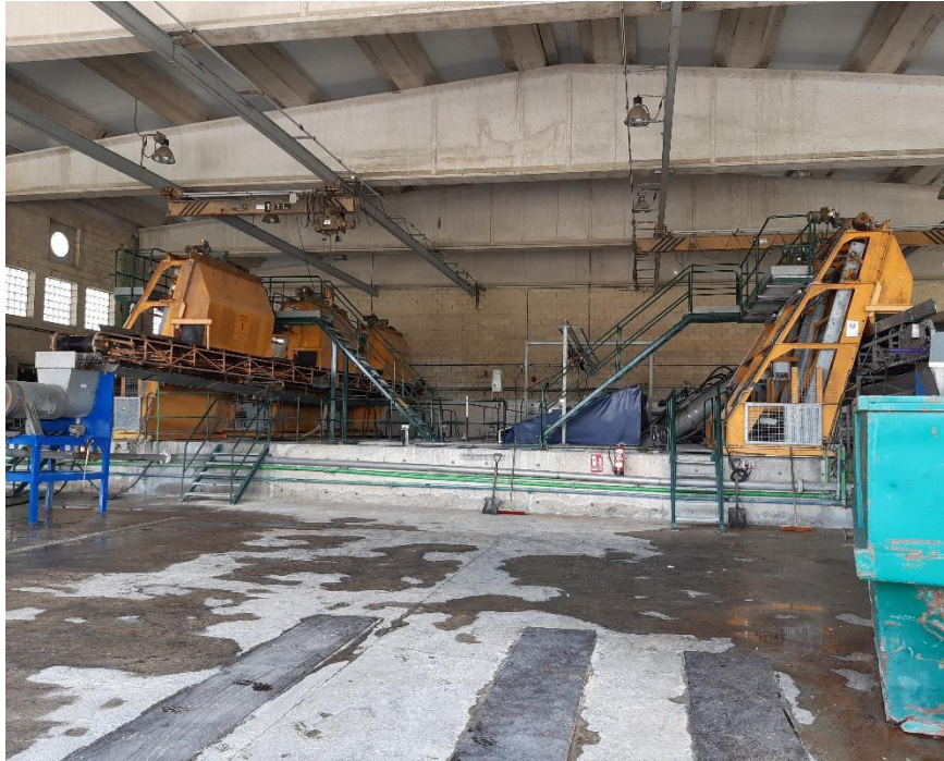
Vista de los dos polipastos existentes en cubierta a desmontar y retirar.
