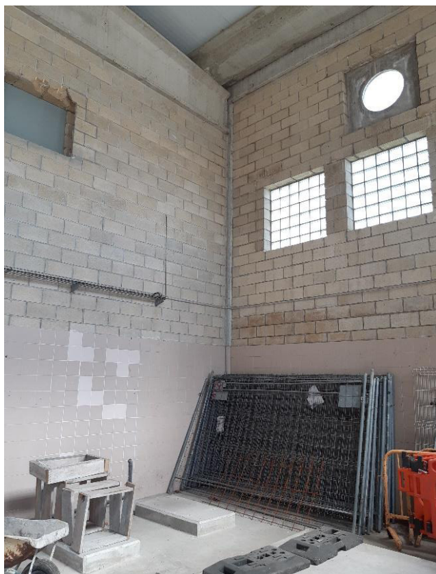
Vista de la sala de desodorización. Al fondo y en la esquina, el pilar medianil con la sala de rejás. En la base, las bancadas existentes.
