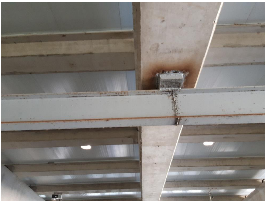
Detalle de la placa de anclaje de unión entre las vigas carril de los polipastos y las vigas delta de la cubierta.
