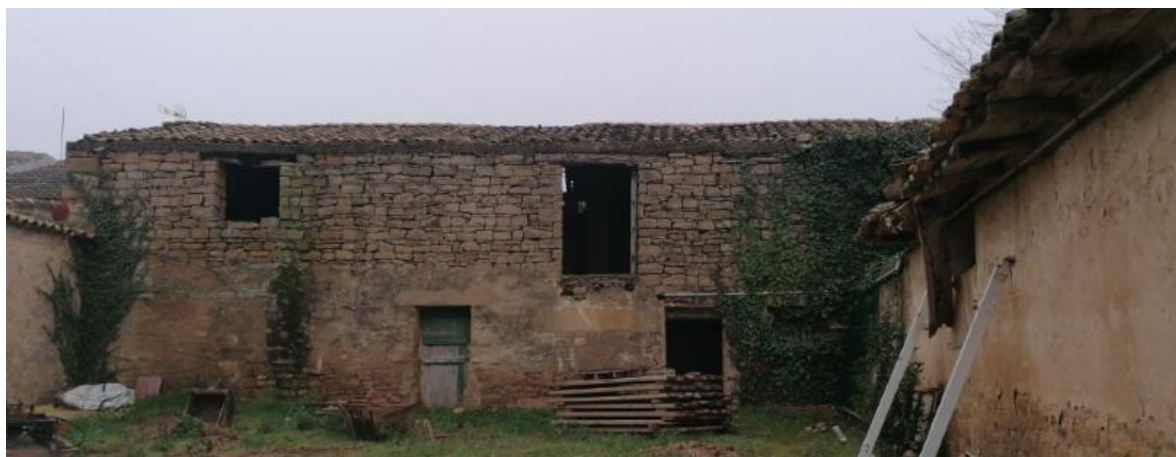
Vista desde el interior de la parcela
