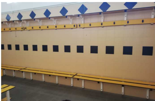
Zona de bancos y perchas con estantería arriba en vestuario hombres y el mismo en vestuario mujeres
