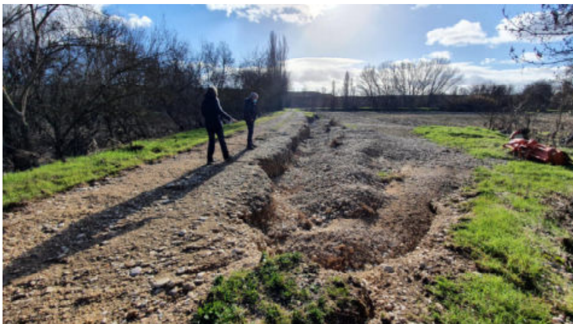
Otra fotografía del camino donde la riada ha erosionado la capa de rodadura e incluso talud terraplén
