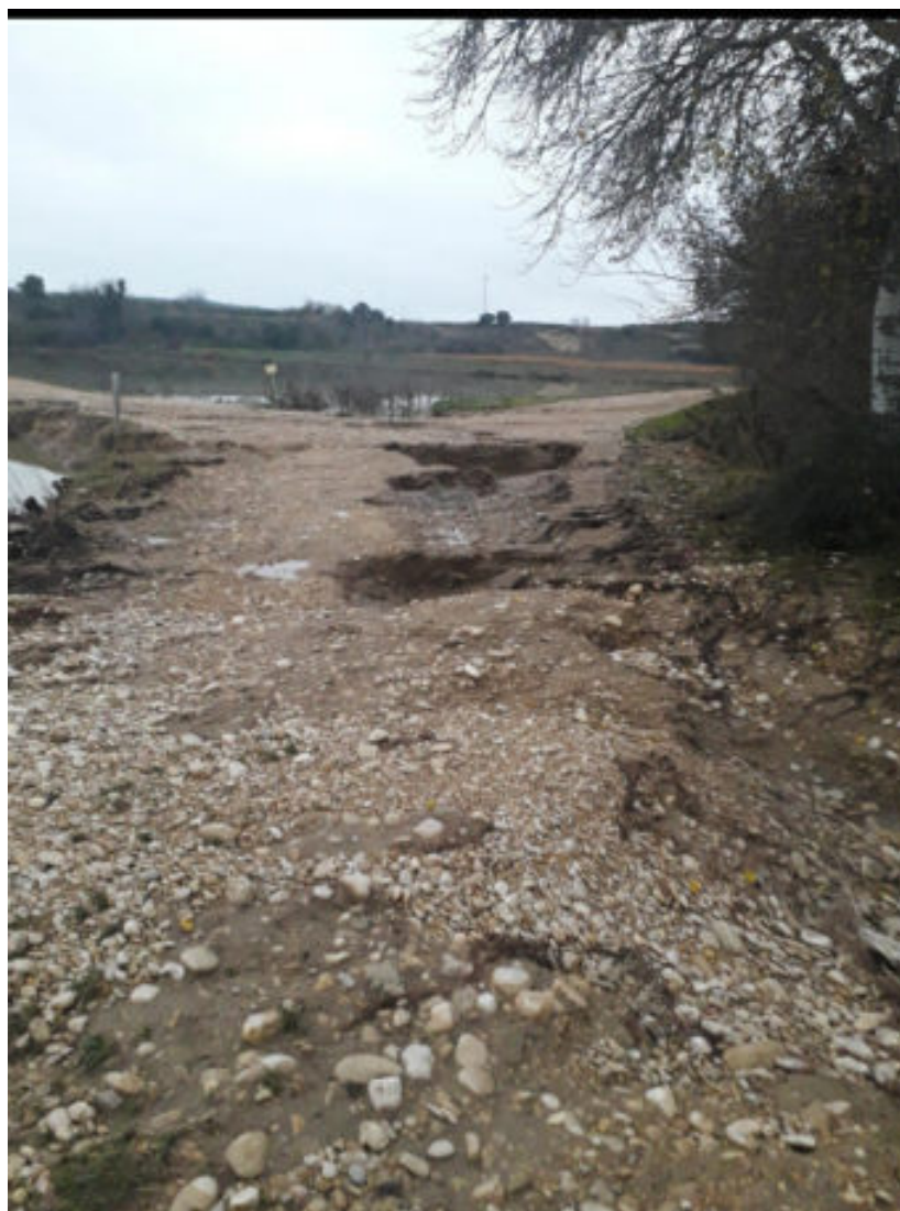
Camino donde la riada ha erosionado provocando socavones
