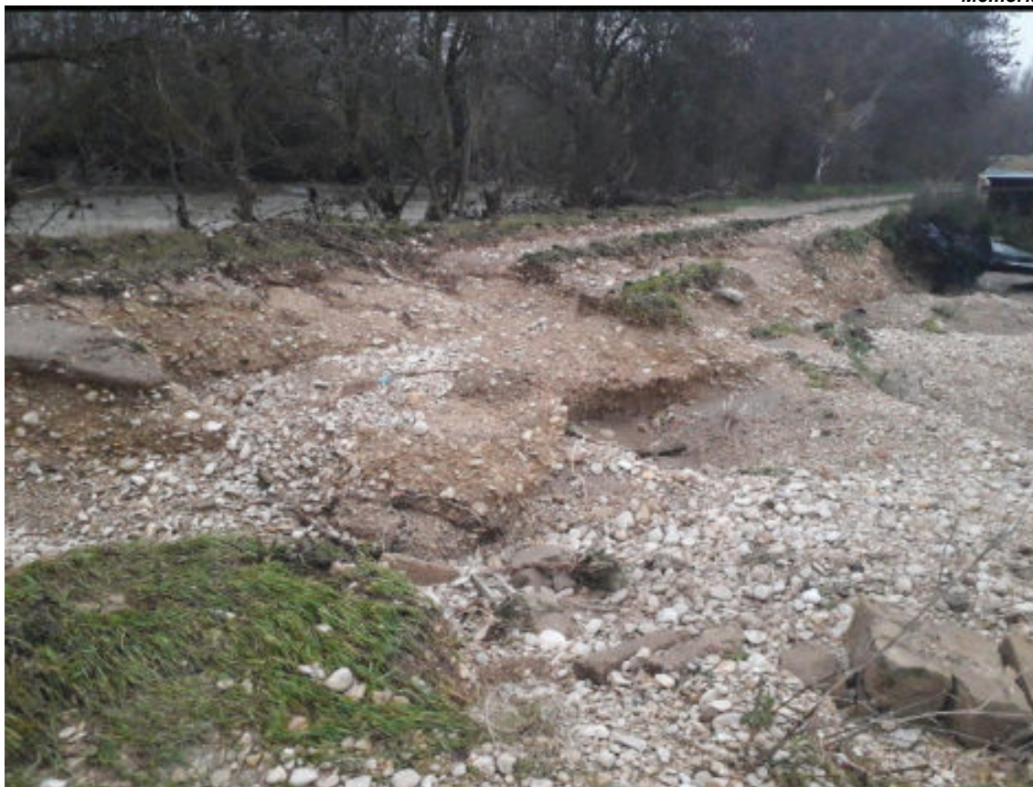
Otra fotografía del camino donde la riada ha erosionado provocando socavones
