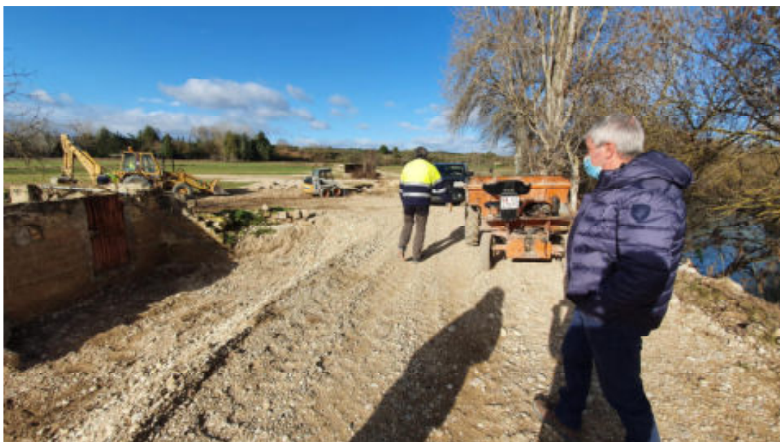
Fotografía del camino realizando las reparaciones de los socavones con personal del ayuntamiento de Lerín
