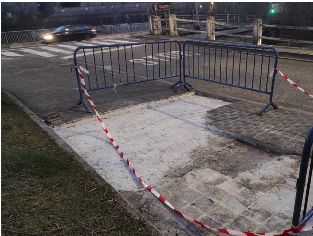
Imagen de una zona de acera de baldosa hidráulica levantada después de la riada
