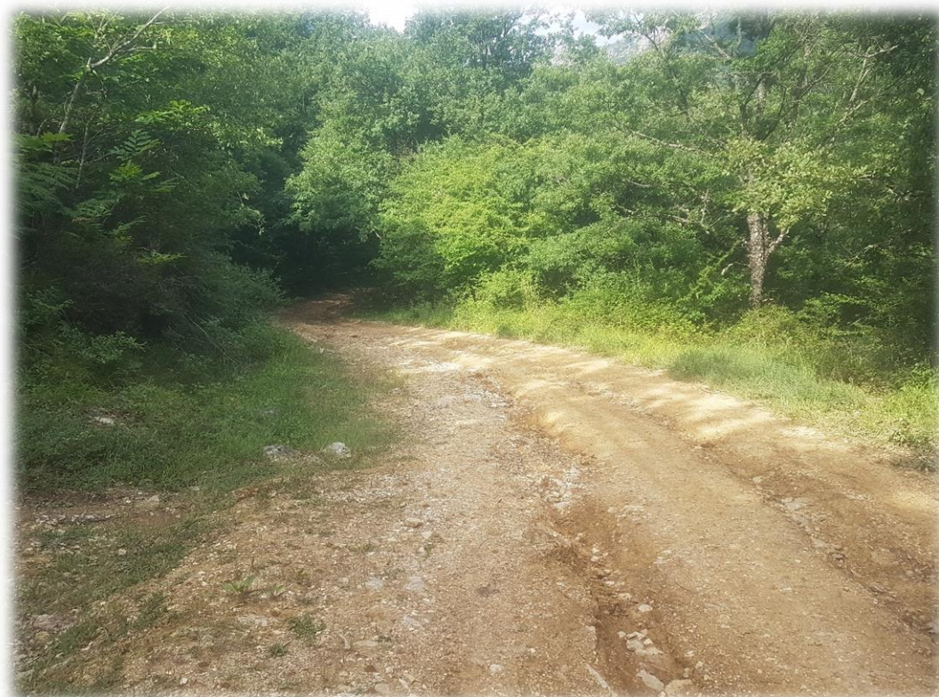
Fotografía 6: Vista general arrastre de material y roderas.
