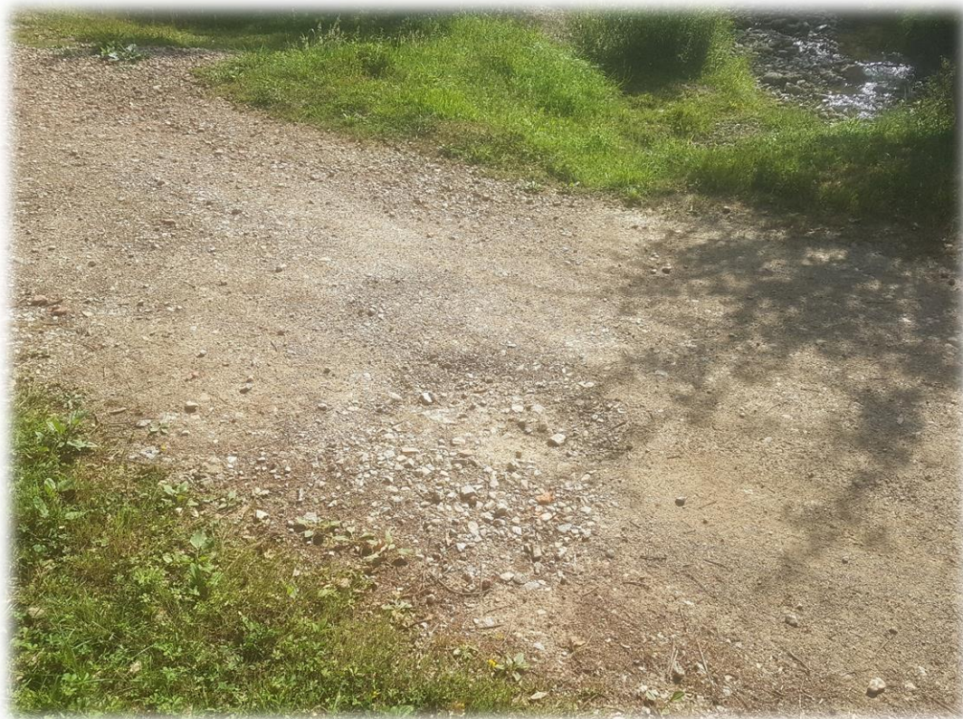
Fotografía 1: Tramo 1, construcción de Badén de drenaje
