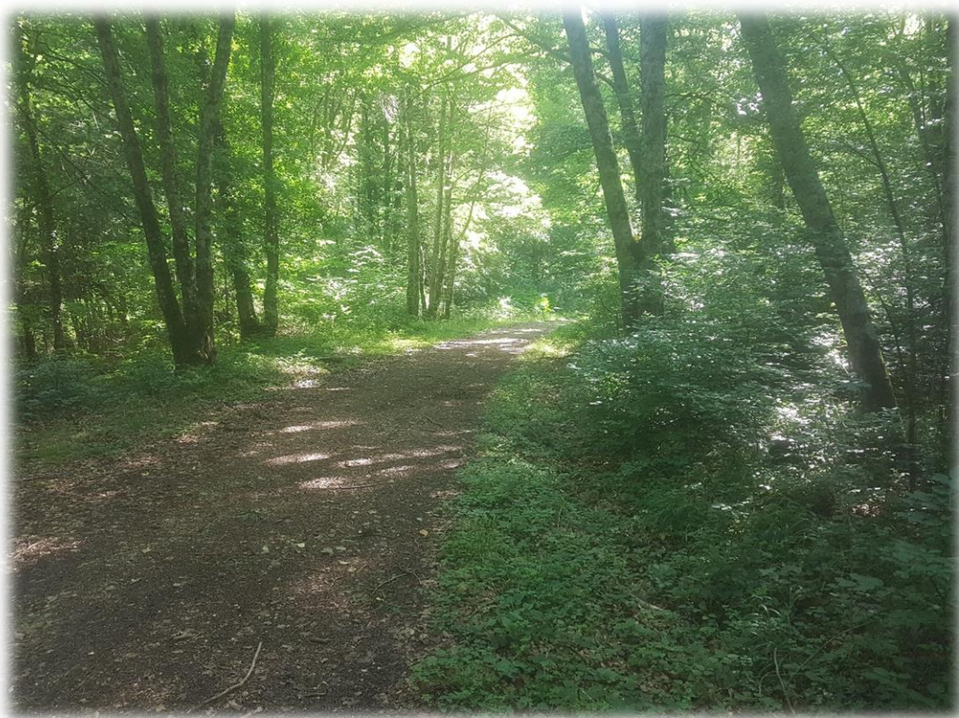
Fotografía 10: Fin de la zona de actuación, vista de la cuneta completamente tapada.
