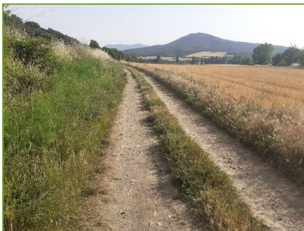
Detalle del estado de la cuneta y presencia de cordones de vegetación que impiden un correcto desagüe.
