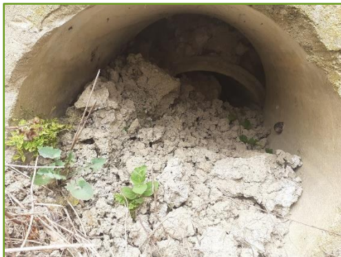
Paso de agua hundido en camino Udarandipea
