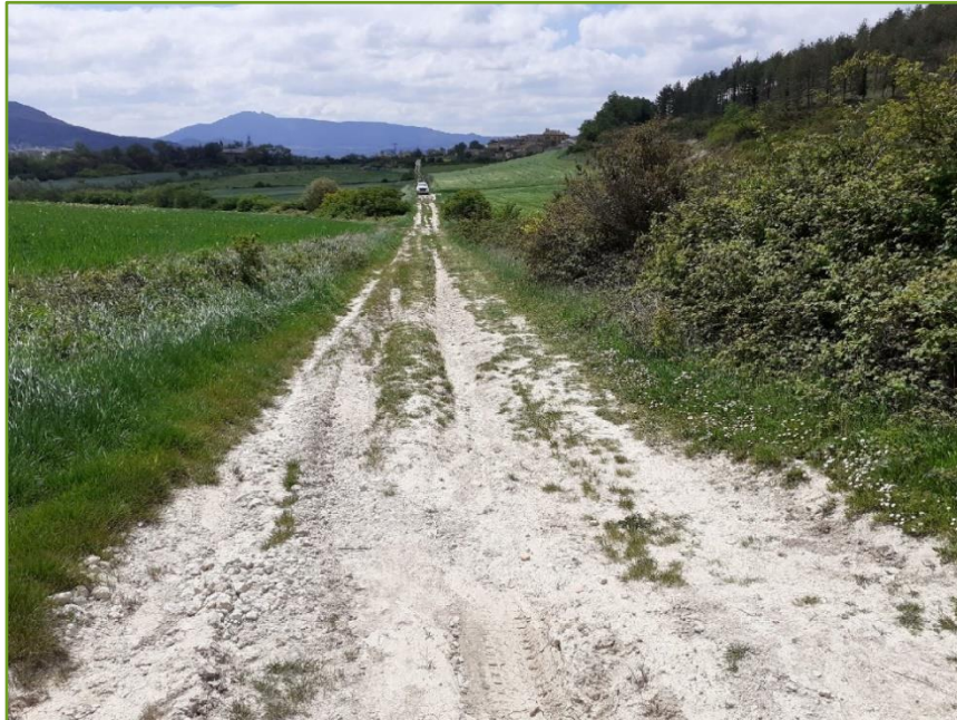
Detalle de explanación con irregularidad superficial en el camino de las culebras (Concejo de Muneta)
