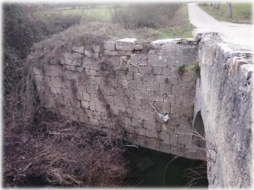
Fotografía 3: Vista general estribo de aguas abajo, margen derecha
