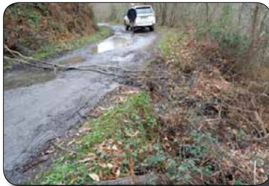
Usategieta-Landagaita. Asentamiento en terraplén
