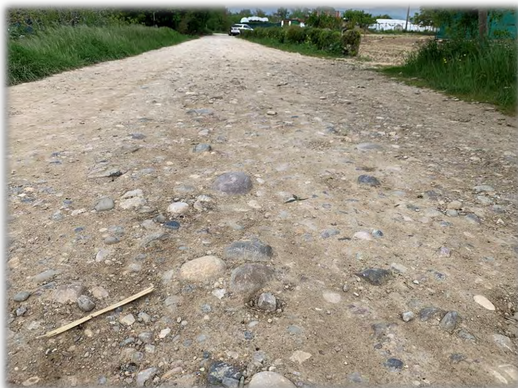
Fotografía 1: Vista general del camino, con subbase a la vista, debido a la pérdida de la rodadura por la erosión de la inundación
