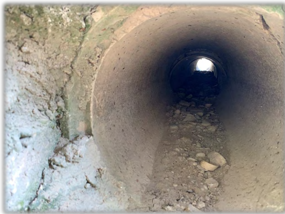
Fotografía 7: Vista interior caño a limpiar
