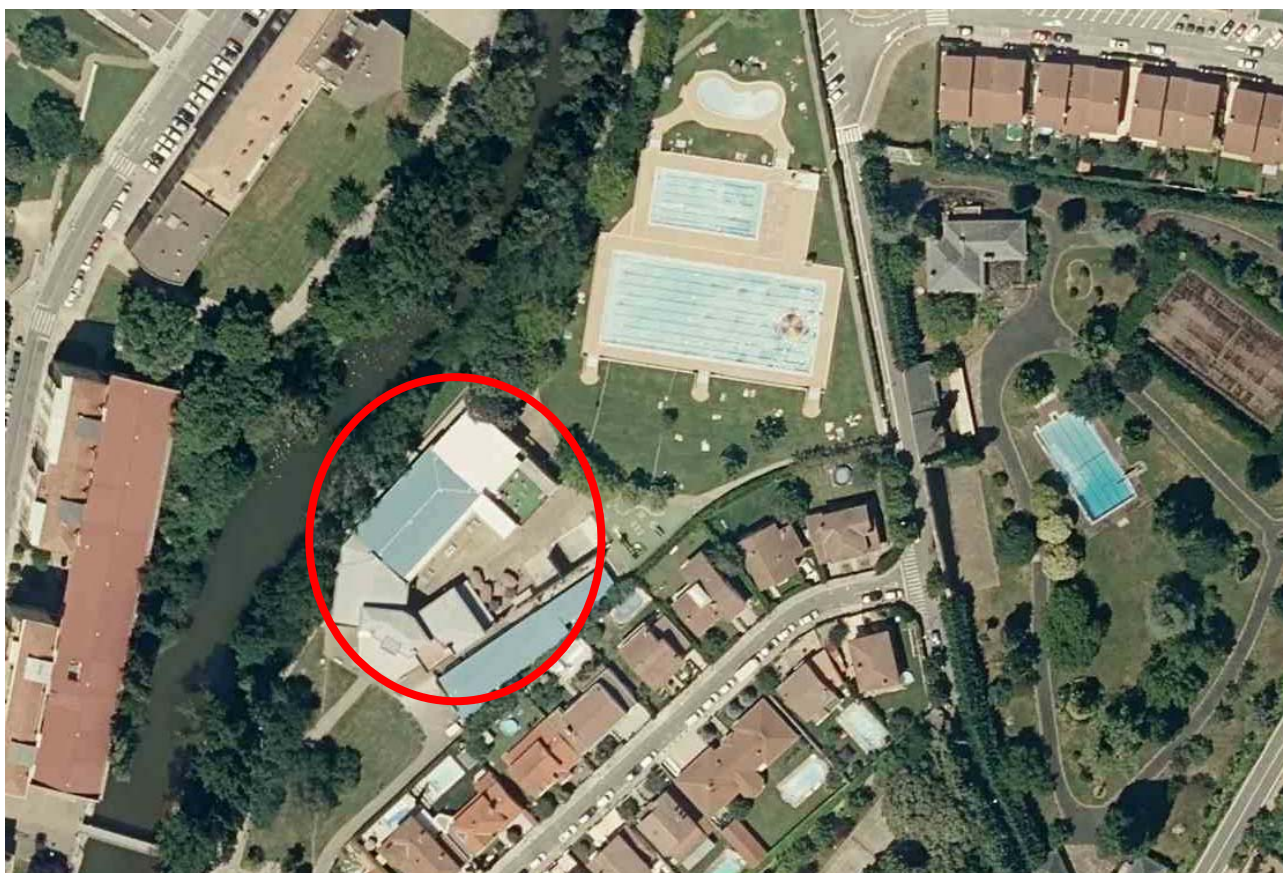
Edificio social, junto al río Ultzama
