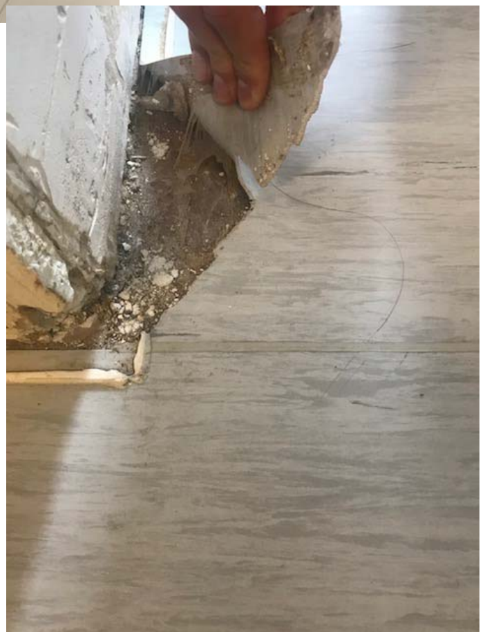
Imagen del revestimiento del suelo de las salas.
