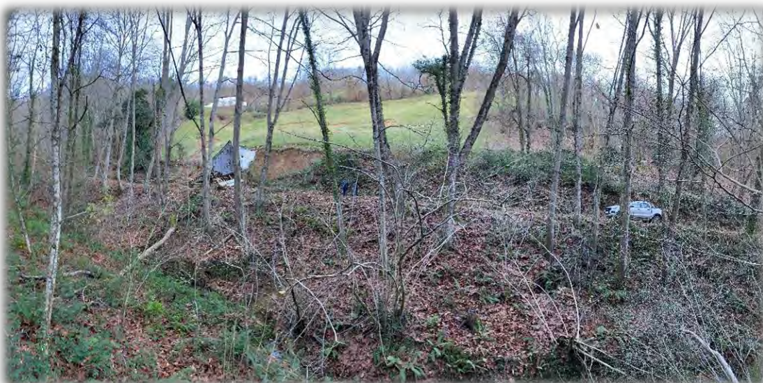
Fotografía 11: Perspectiva del deslizamiento desde el otra margen de la regata.
