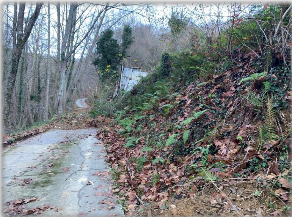
Fotografía 2: Material del deslizamiento sobre el camino, se observa al fondo el contenedor caído.
