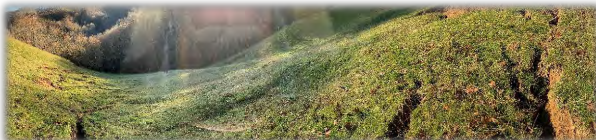
Fotografía 6: Perspectiva del deslizamiento de la ladera, el camino está al fondo, a unos 7 m de la cabeza de talud de la ladera.
