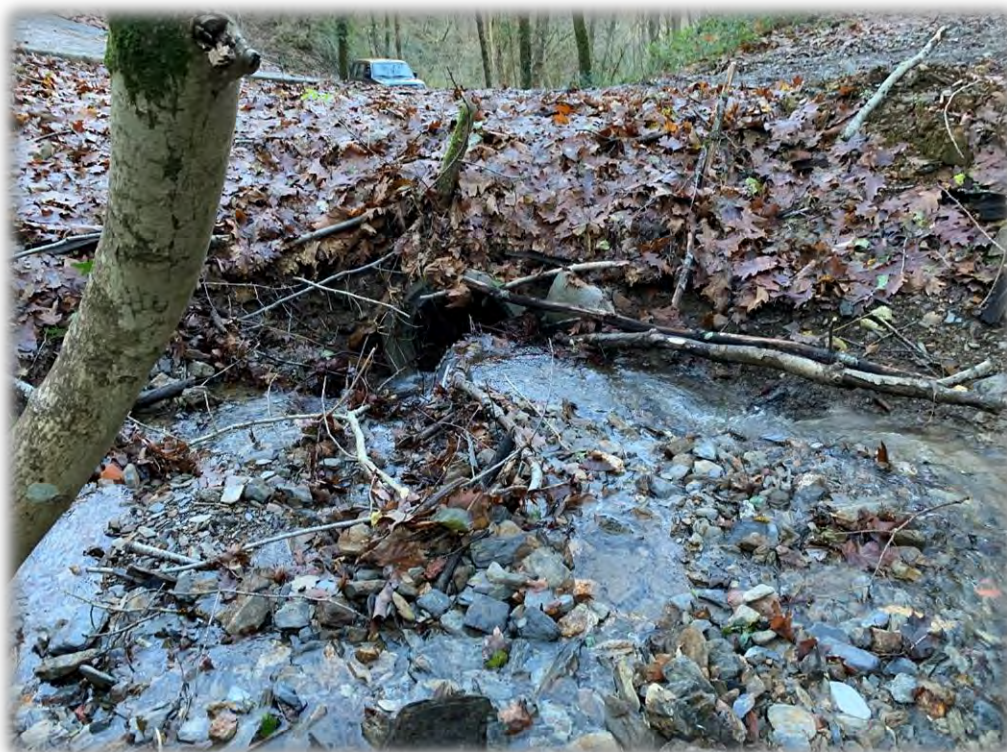
Fotografía 18: Boca de entrada a obra de fábrica a limpiar y proteger.
