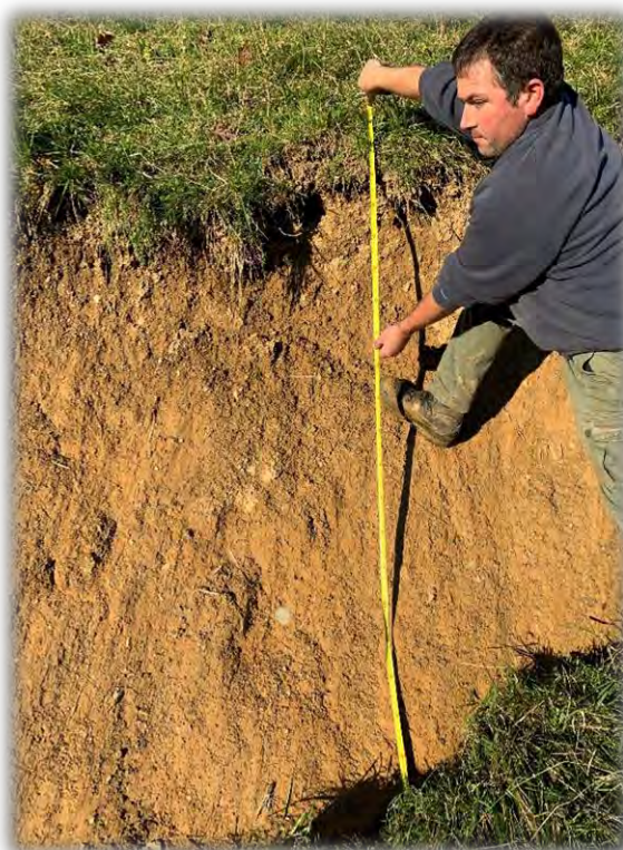
Fotografía 5: Escalón creado en la ladera por el deslizamiento de esta.
