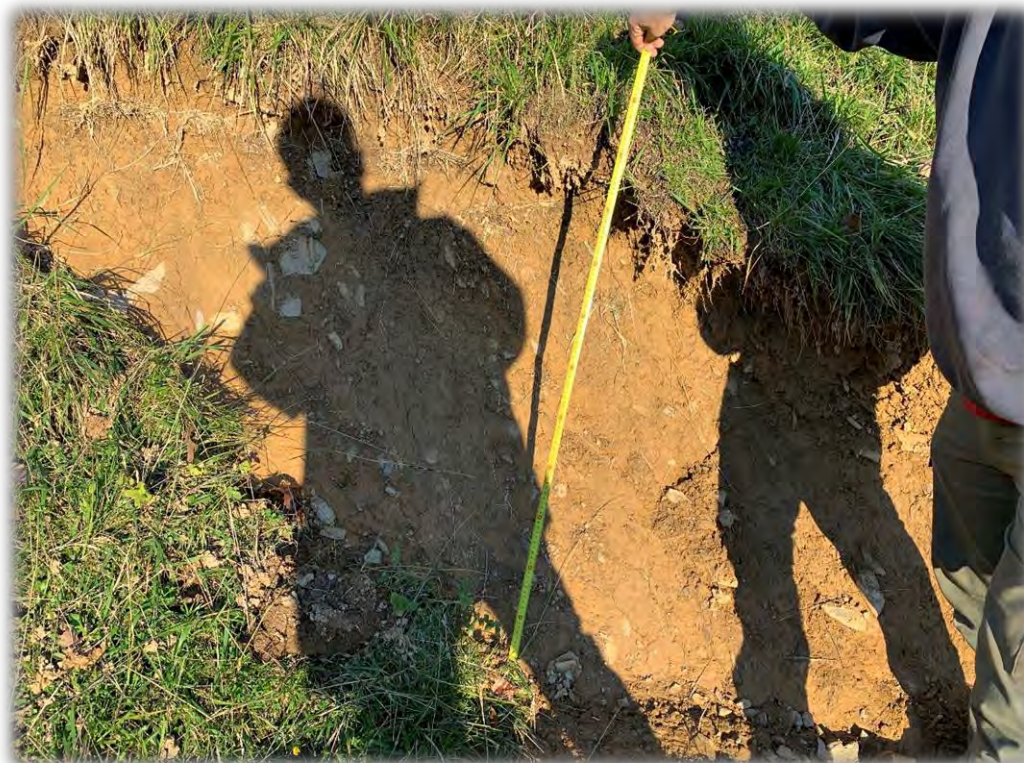
Fotografía 4: Escalón creado en la ladera por el deslizamiento de esta.
