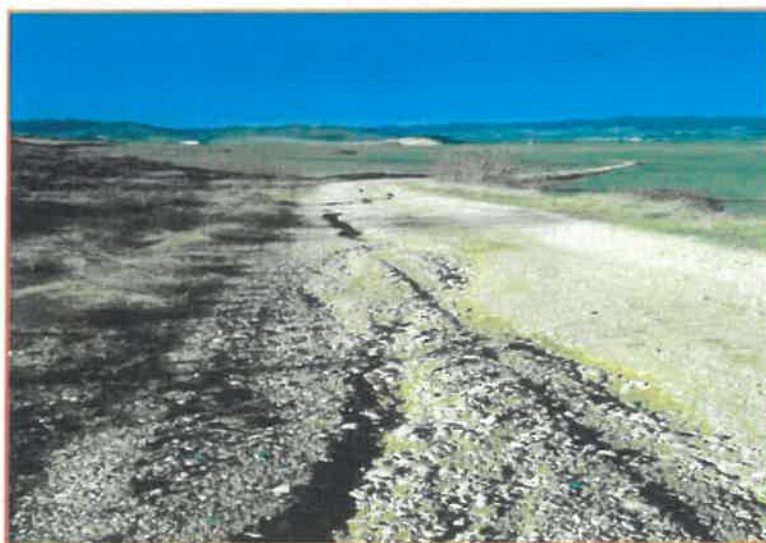
Imagen 4: Estado actual de tramo de vial de Reta susceptible de perfilado y aporte zahorras
