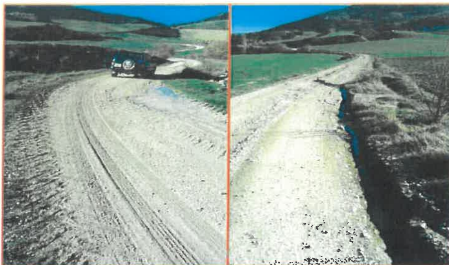
Fotos 1 y 2. Detalle de tramo de vial 1 objeto de saneamiento y drenaje de balasto (izda) y detalle de tramo del mismo vial 1 con daños en capa de rodadura por escorrentía tras colmatación de cuneta (dcha).
