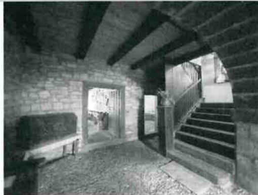
Escalera P0. Acceso a Establos y sala P0.04
