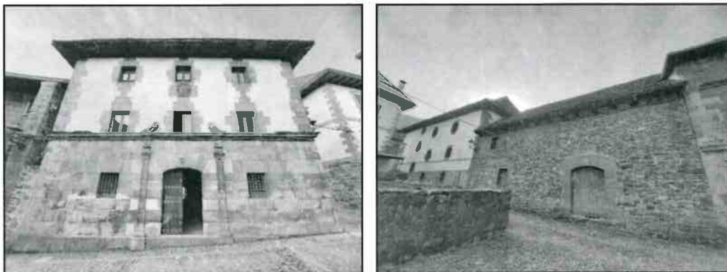
Imagen 2: imágenes de fachadas
