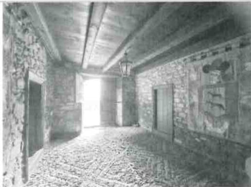
Distribuidor P0. Puerta acceso principal
