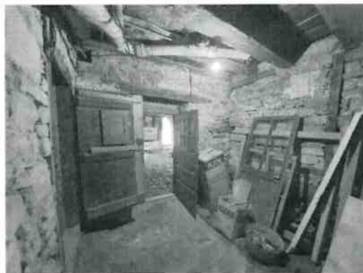
Sala P0.03. Acceso a Anexo desde Establos
