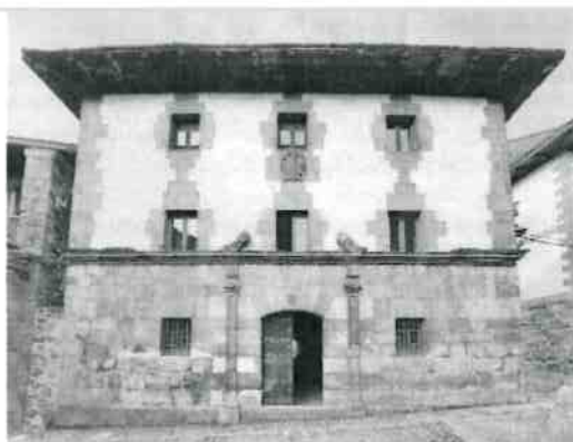
Fachada Oeste. Acceso principal
