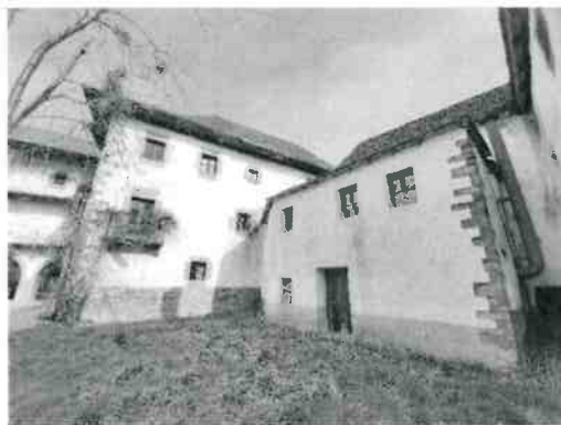
Fachada interior Sudoeste. Anexo
