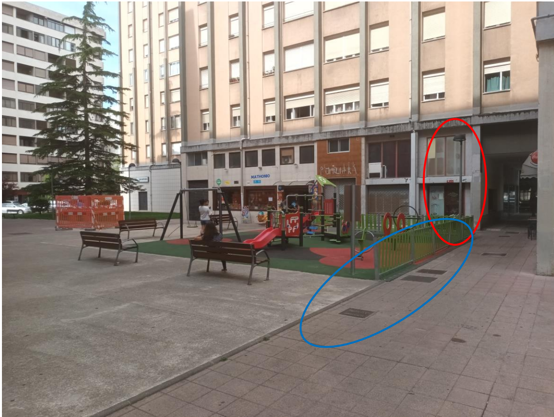
Imagen del parque infantil existente en la calle San Esteban. Se señala en rojo la luminaria existente de alumbrado público. Se señalan en azul las arquetas correspondientes a la canalización de alumbrado.
