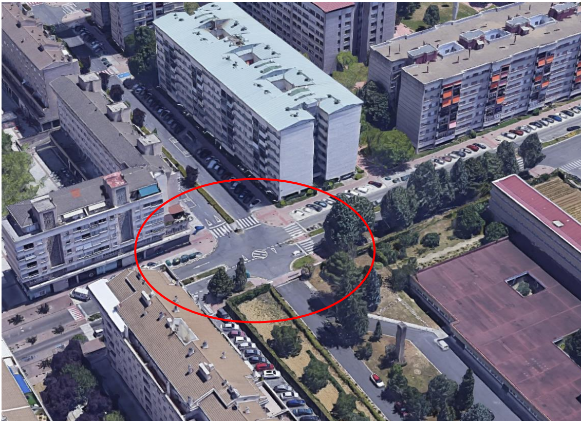
Fotografía aérea de uno de los ámbitos de actuación (se señala en rojo).
