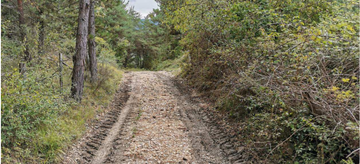
Figura 2. Tramo 1 del camino a mejorar
