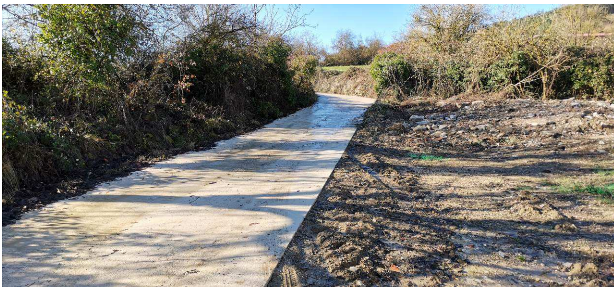
Figura 5. Camino a su salida desde el pueblo, hormigonado el año 2021
