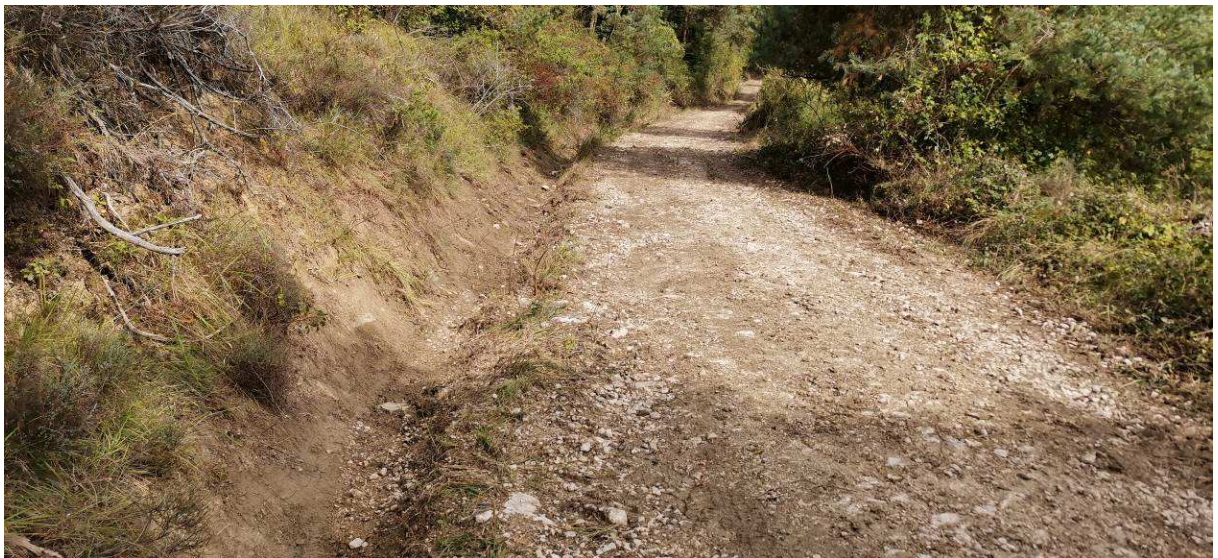
Figura 3. Tramo 2 del camino, con la dotación de áridos ya realizada
