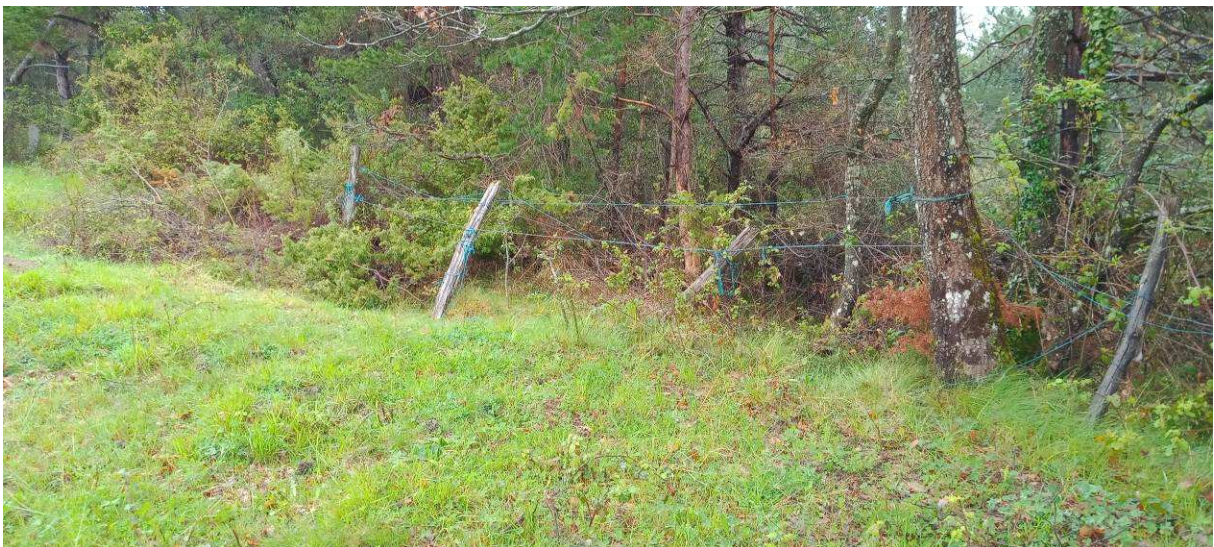
Figura 6. Vista del cierre a renovar
