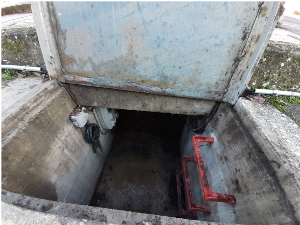
Detalle de la arqueta de acceso al foso de la segunda báscula.
