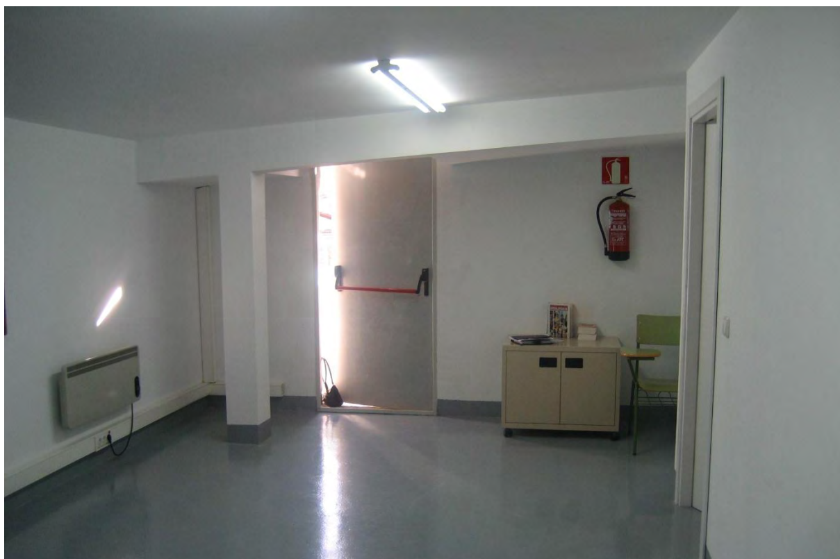
Puerta que da paso a la escalera de emergencia en planta tercera. En este caso es de 1 hoja de anchura 80 cm.
