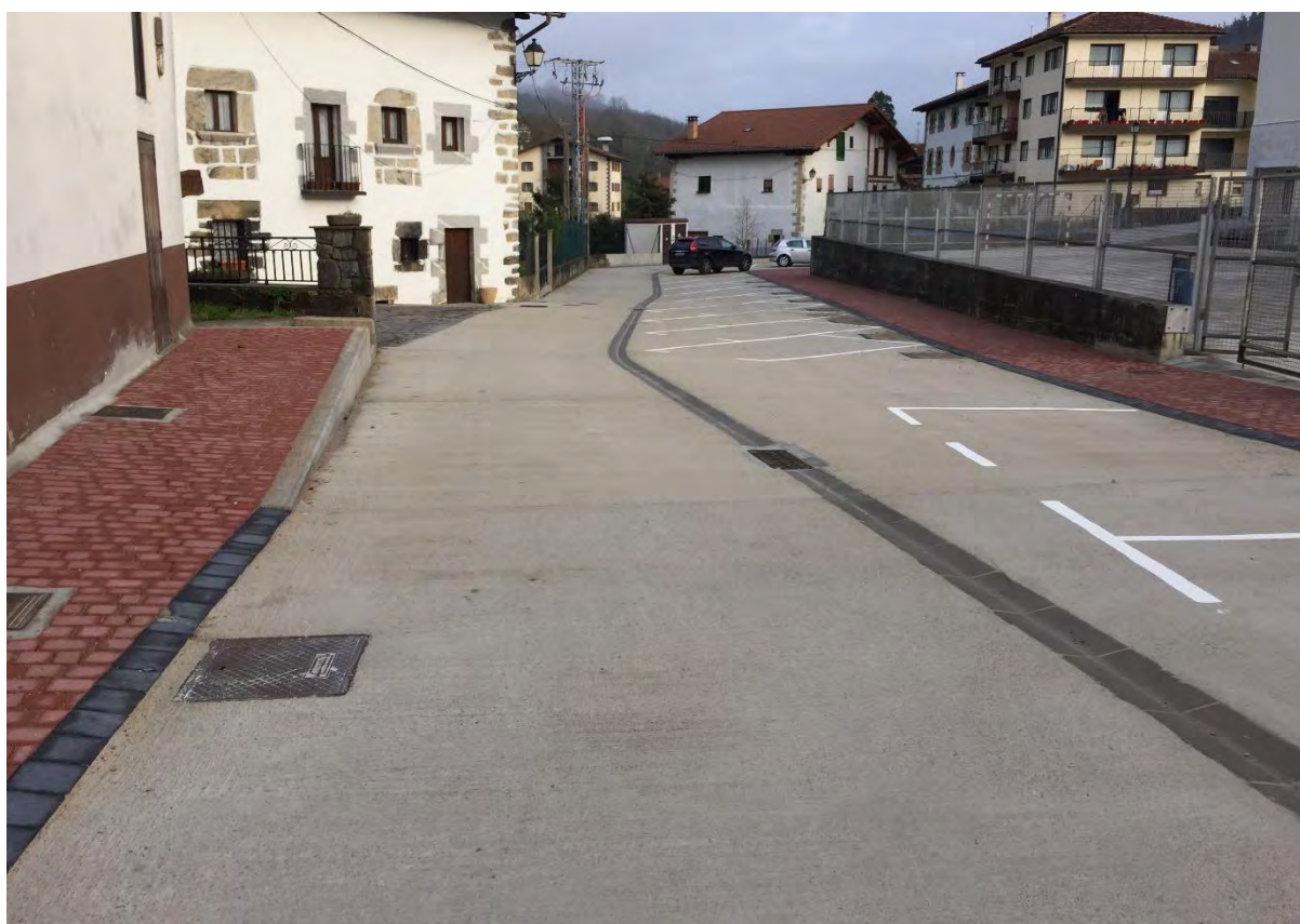
A la derecha se observa el acceso secundario al patio del colegio: este reúne condiciones de accesibilidad.
