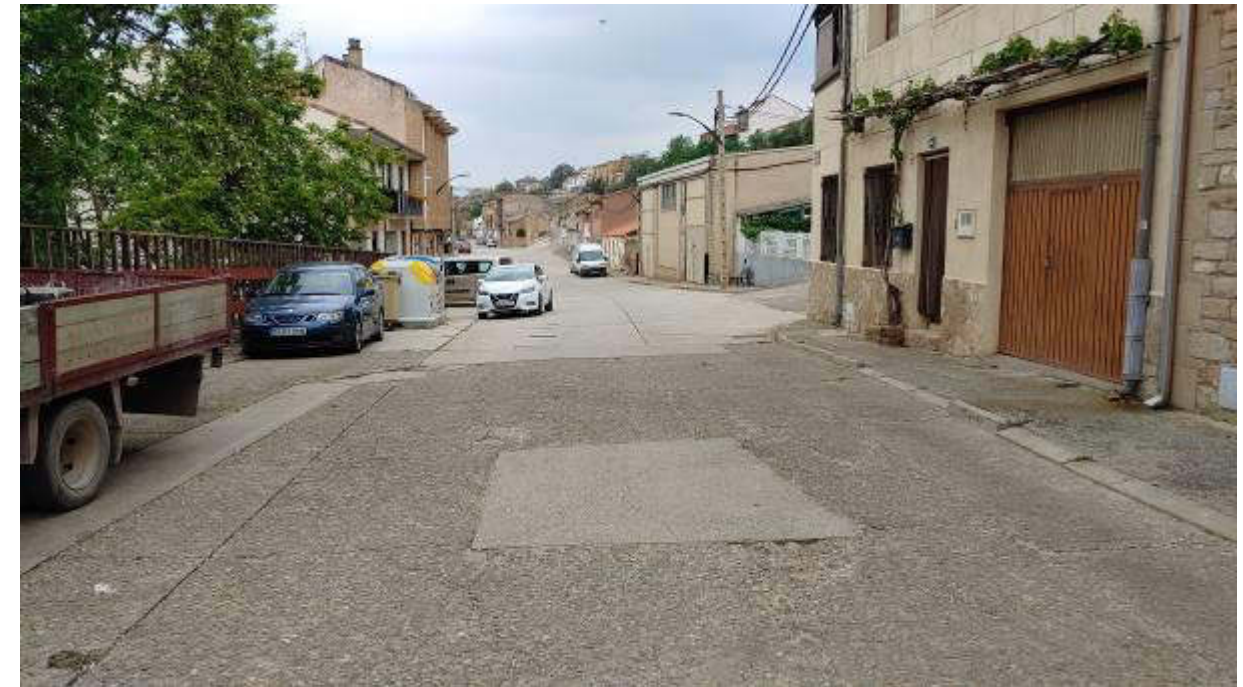
Tramo final de la actuación
