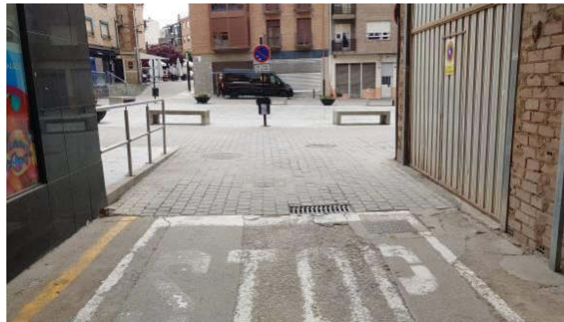
Inicio obras (Plaza los Fueros)
