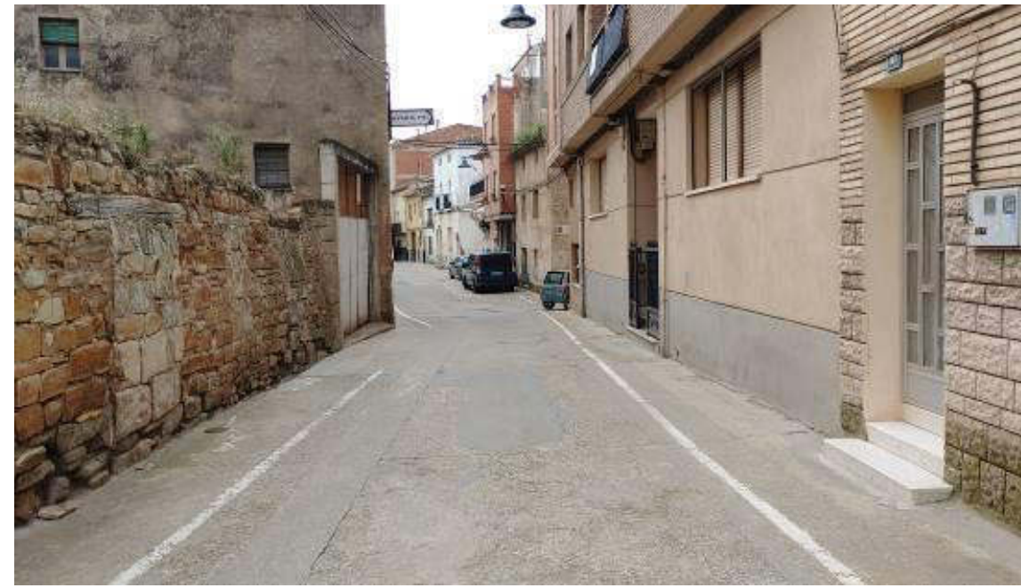
Escaleras invadiendo la calle
