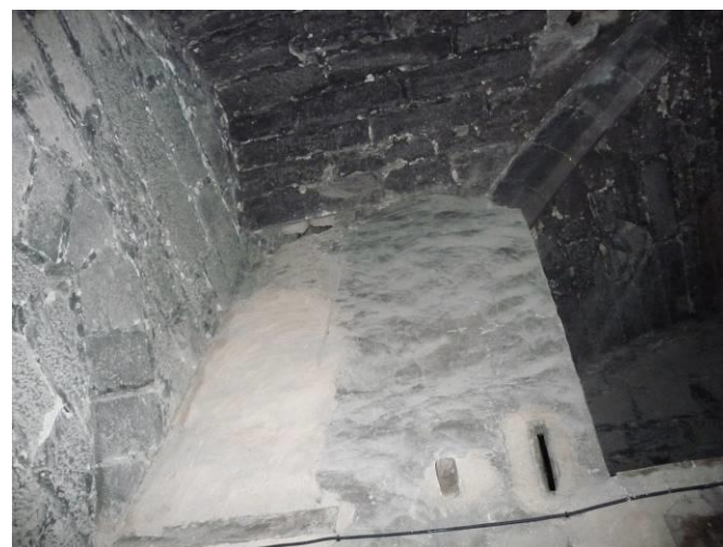
Arriba a la izquierda, detalle de ménsula y nervio de la bóveda. El resto de las imágenes muestran el cierre de albañilería existente en el ángulo sureste de la estancia construido para permitir el paso de las pesas del primer reloj. La imagen superior muestra que falta parte de la plementería y que el relleno sobre el trasdós está contenido lateralmente por el levante de albañilería.
