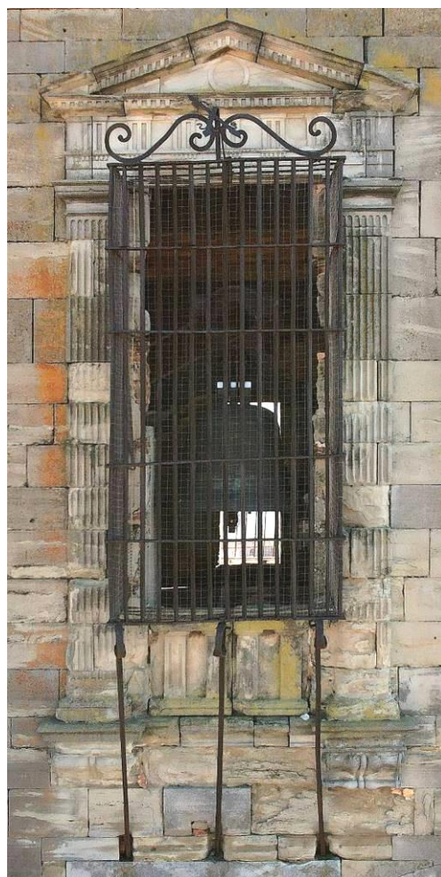
Izquierda, hueco de la fachada norte; derecha, hueco de la fachada oeste. Fuente: IPV
