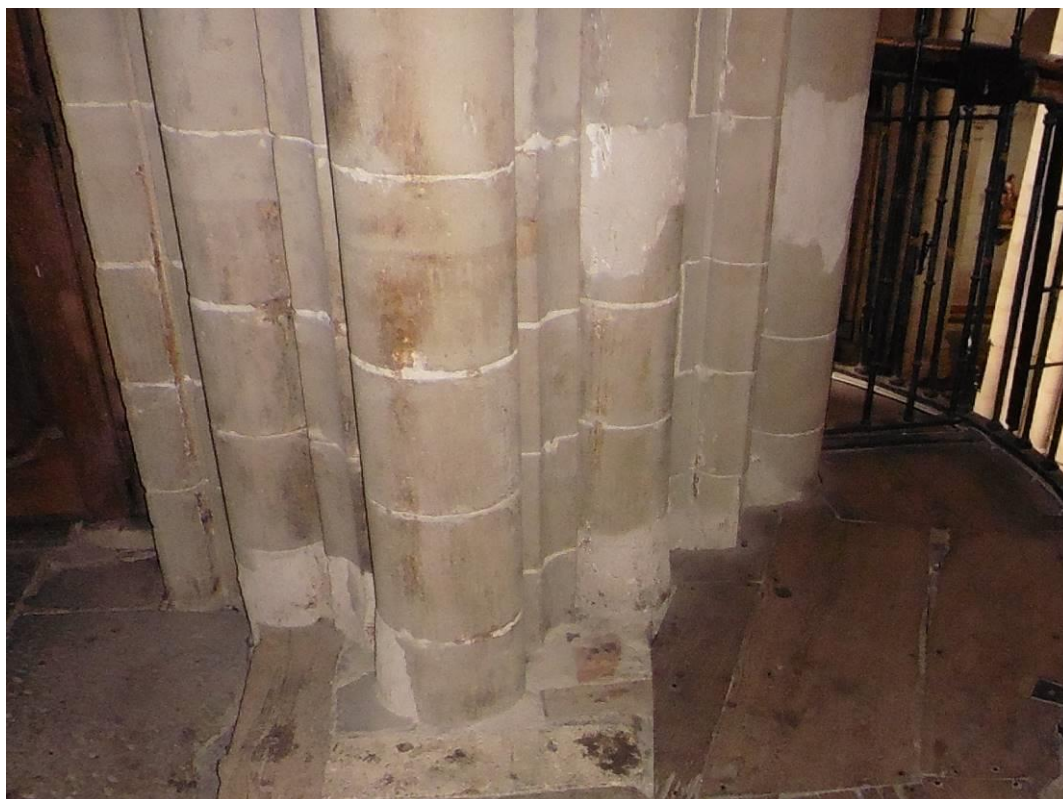
Reparaciones de mortero en el lado meridional del pilar de la torre en el nivel del coro. Fuente: IPV
