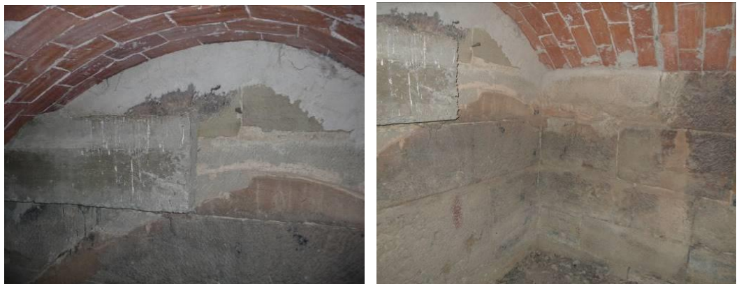
Detalles en los que se intuye la huella de la bóveda del tramo de arranque de la antigua escalera. En la imagen de la derecha se distingue el refuerzo de hormigón de apoyo de la cubierta de la nave principal. Fuente: IPV
