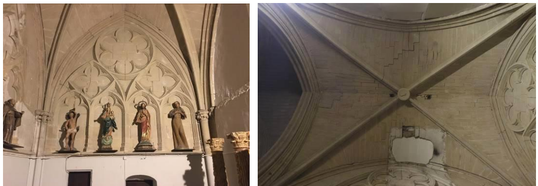
Izquierda, tracería ciega del muro occidental detrás de la cual discurre el pasadizo del triforio occidental. Derecha, bóveda que cubre el segundo nivel de la torre. Fuente: IPV
