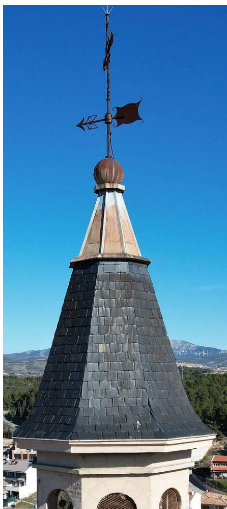
Cubierta del chapitel. Izquierda, cara sur; derecha, detalle de la cara oriental en el que se aprecian algunas piezas desprendidas y movidas y la chapa de cinc para solventarlo. Fuente: IPV
