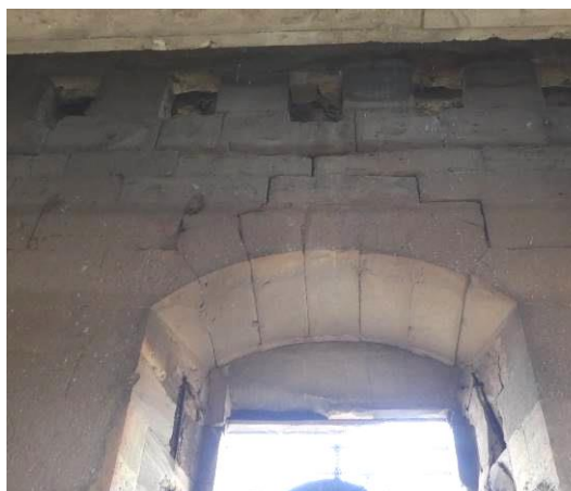
Grietas en el muro occidental. Izquierda, exterior; derecha, interior. Fuente: IPV
