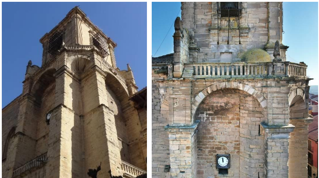
Exterior de la torre, detalles que muestran la transici n de la estructura g tica a la renacentista. Fuente: IPV
