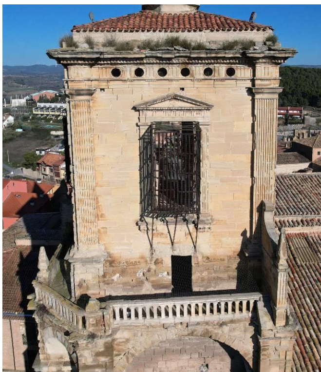
Parte superior de la torre de la iglesia de Santa María de Viana. Arriba, fachada oeste; abajo, detalle de la fachada sur. Fuente: IPV
