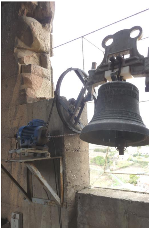
Mecanización de las campanas. Arriba a la izquierda, la campana oriental; a la derecha la meridional. Abajo a la izquierda, la occidental; a la derecha, la septentrional. Fuente: IPV
