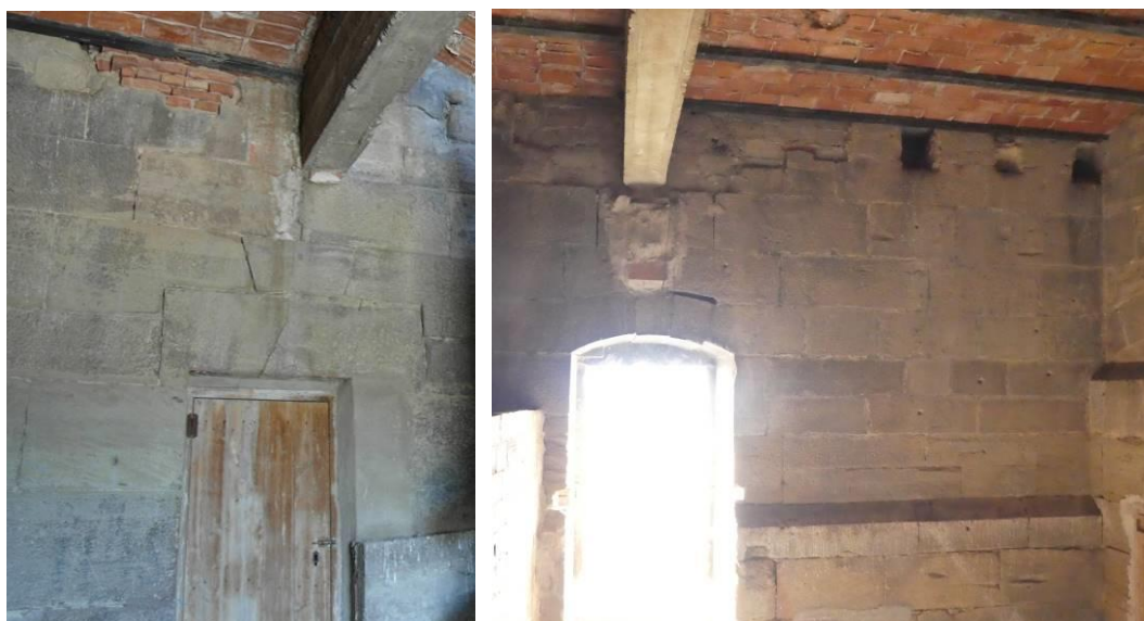
Planta baja del cuerpo de campanas. Izquierda, vano septentrional de paso a la bajocubierta. Derecha, vano meridional de acceso a la terraza. Fuente: IPV
