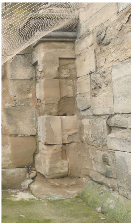
Izquierda, pedestal septentrional de la fachada oeste. Derecha, degradación del zócalo biselado de la fachada sur. Fuente: IPV
