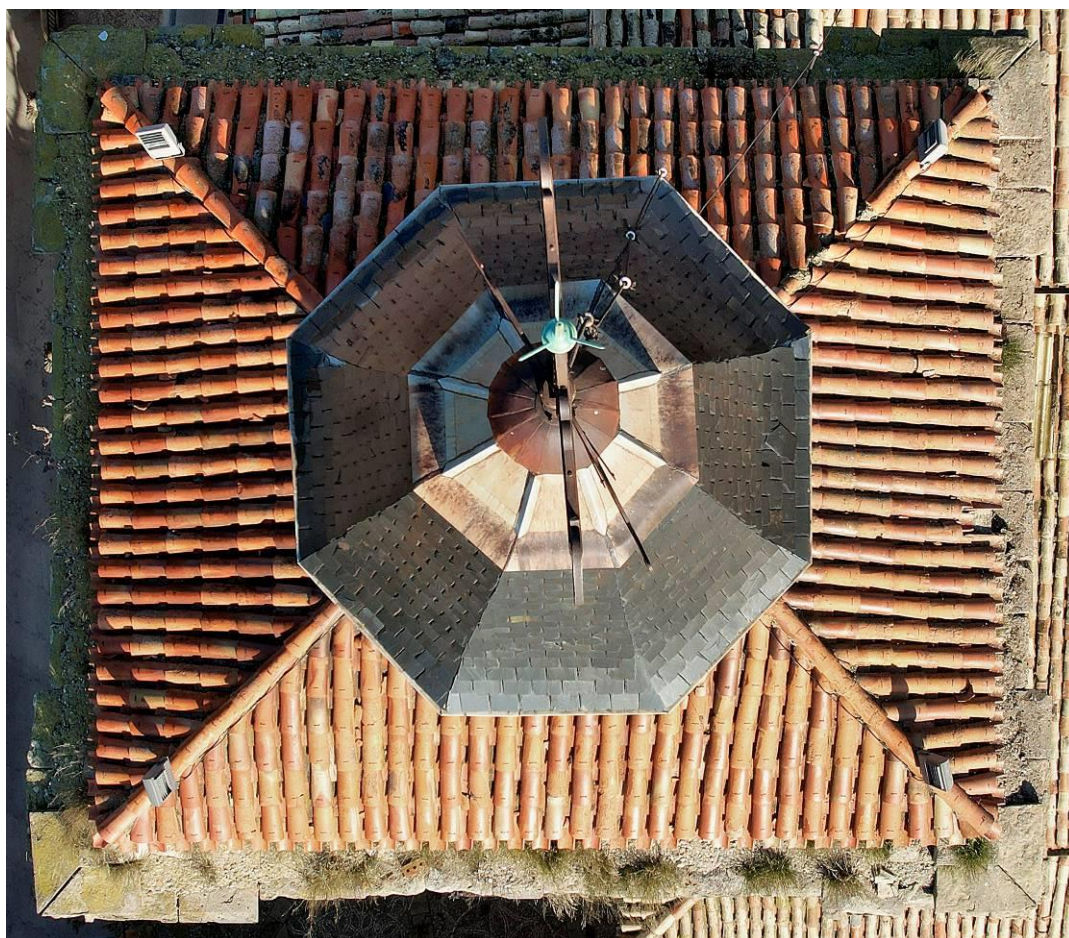
Arriba, ortofoto de planta de la cubierta del chapitel, orientada hacia el norte. Abajo, detalle del aguilón noreste y el encuentro de los faldones con la linterna. Fuente: IPV
