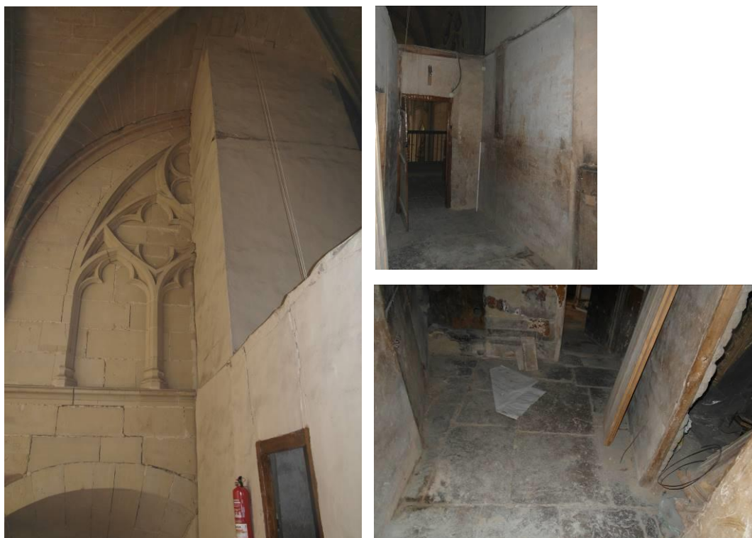
Tabiques que compartimentaban el coro en el tramo de la torre, derribados en 2018. Fuente: IPV
