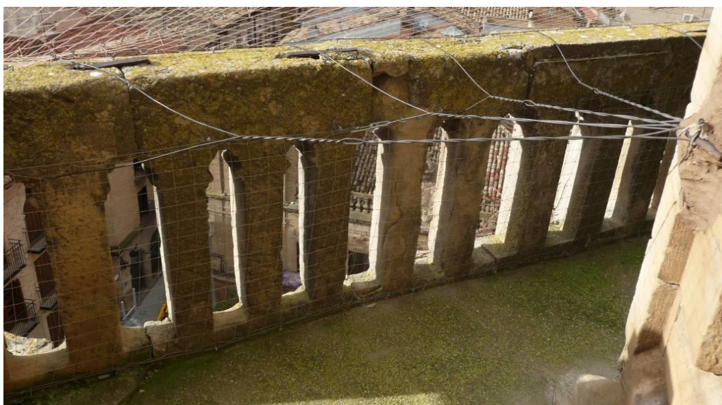
Balaustrada del lado suroeste unidas con grapas. Fuente: IPV
