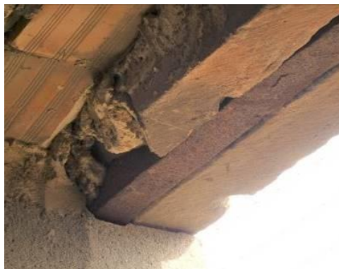
Detalle de los flejes de hierro encajados en la cara inferior de los dinteles de los huecos del cuerpo de campanas. Fuente: IPV
