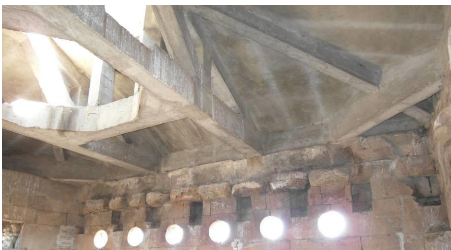
Estructura de hormigón de la linterna y de los faldones de la cubierta de la torre. Fuente: IPV
