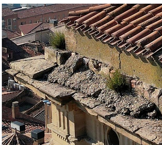
Detalles de la coronación de la torre en los que se aprecia, sobre la cornisa, la última hilada de los muros. Se distinguen las cajas para el apoyo de solivos de una antigua cubierta y las losas en inglete de las esquinas. Fuente: IPV
