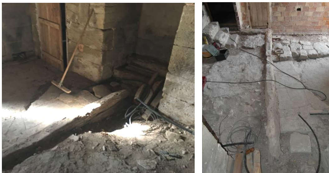
Planta baja del cuerpo de campanas. Detalle de la viga de madera semiempotrada de oeste a este. Fuente: IPV
