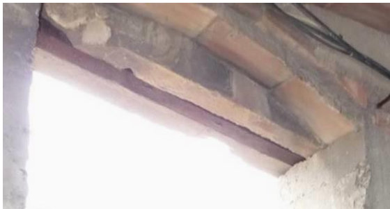
Detalle de los flejes de hierro encajados en la cara inferior de los dinteles de los huecos del cuerpo de campanas. Fuente: IPV
