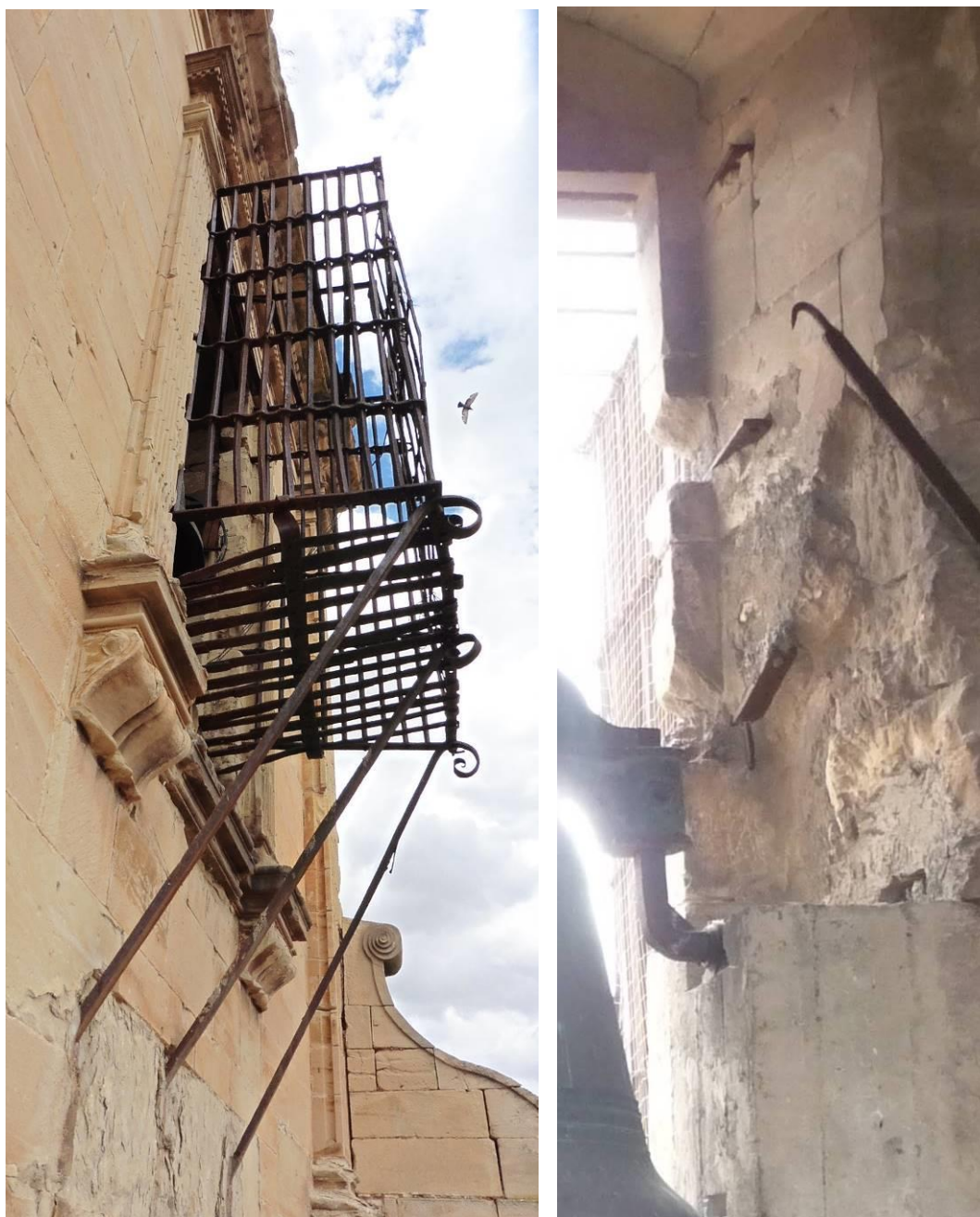
Reja del hueco occidental. Izquierda, detalle del encuentro de los tornapuntas de refuerzo con la fábrica de sillería. Derecha, detalle de pletinas de anclaje laterales atravesando los sillares de las jambas. Fuente: IPV
