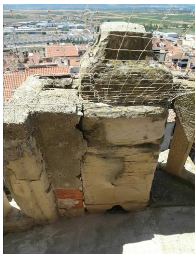
Balaustrada del lado suroeste unidas con grapas. Fuente: IPV
