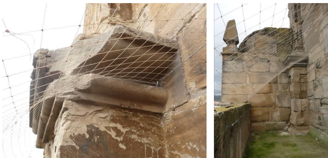
Redes que impiden el acceso a las palomas a la terraza. Fuente: IPV
