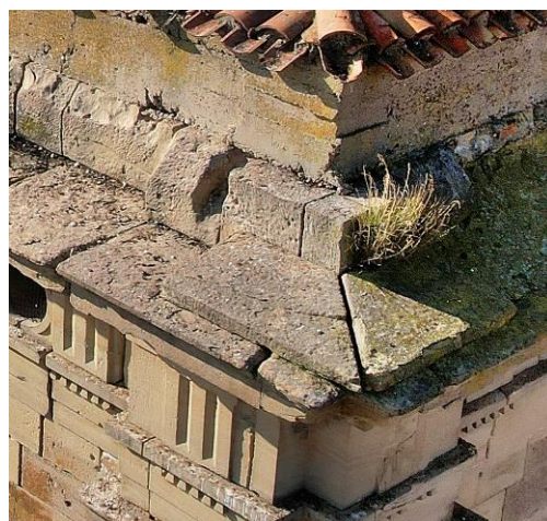
Detalles de la coronación de la torre en los que se aprecia, sobre la cornisa, la última hilada de los muros. Se distinguen las cajas para el apoyo de solivos de una antigua cubierta y las losas en inglete de las esquinas. Fuente: IPV
