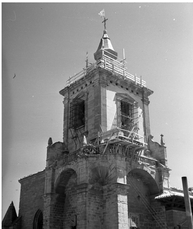
Ejecución de la cubierta en 1954. Fuente: archivo IPV
