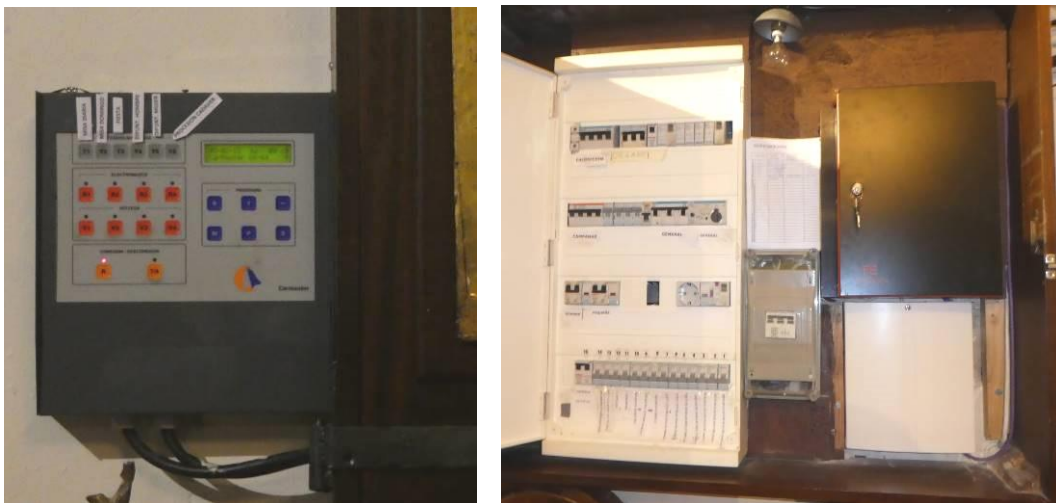
Izquierda, cuadro de maniobra de las campanas; derecha, cuadro general. Ambos situados en el muro oriental de la sacristía. Fuente: IPV
