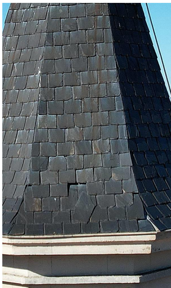
Cubierta del chapitel. Izquierda, cara sur; derecha, detalle de la cara oriental en el que se aprecian algunas piezas desprendidas y movidas y la chapa de cinc para solventarlo. Fuente: IPV
