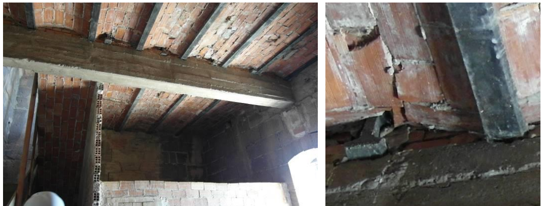
Forjado de vigueta prefabricada de hormigón armado y bovedilla de rasilla apoyado sobre viga de hormigón armado que cubre el espacio del cuarto piso de la torre. Fuente: IPV
