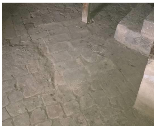
Izquierda, detalle del pavimento de ladrillo en el que se aprecia que se han realizado sucesivas reparaciones. Derecha, campanillos en el hueco abierto en el muro norte de la torre que comunica con el coro. Fuente: IPV
