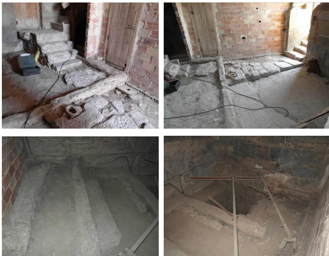
Arriba, detalle de los pasos para las cuerdas de las campanas, losas de piedra y gradas de hormigón que dan acceso a la bajocubierta de la nave central y al tramo de escalera que comunica con la planta superior. Abajo, a la derecha, encuentro de la viga semiempotrada con el muro oriental; a la izquierda, hueco de paso situado en el extremo sureste, con perfiles y cables para la transmisión desde el reloj del accionamiento de los mazos de las campanas. Fuente: IPV
