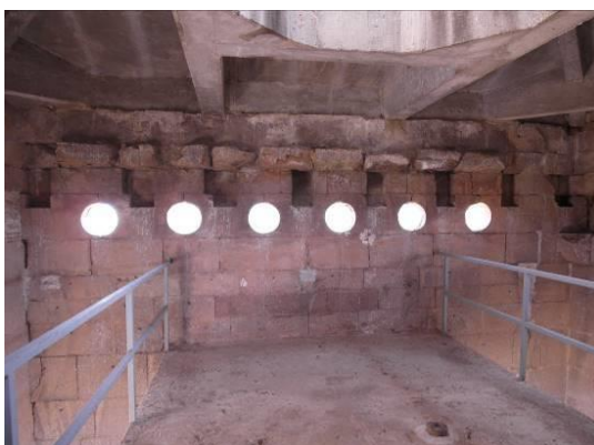
Vistas de la entreplanta parcial y su escalera de acceso. Abajo, detalle de la coronación de los muros, con las cajas de la antigua estructura (izquierda, muro norte; derecha, muro sur) y las colas irregulares de las piezas de cornisa. Fuente: IPV
