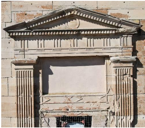
Izquierda, detalle de la parte superior del hueco oriental con el dintel intermedio con motivos geométricos. Derecha, detalle de la parte inferior de la fachada oriental de la torre en el que se ve cómo el hueco de paso sin ornato hacia la cubierta interrumpe el bisel que continúa la moldura inferior de los pedestales. Fuente: IPV
