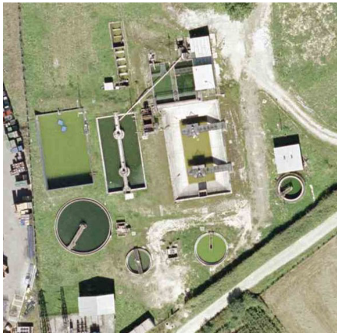
Imagen 02. Vista aérea del año 2002 de la planta de depuración a demoler.
