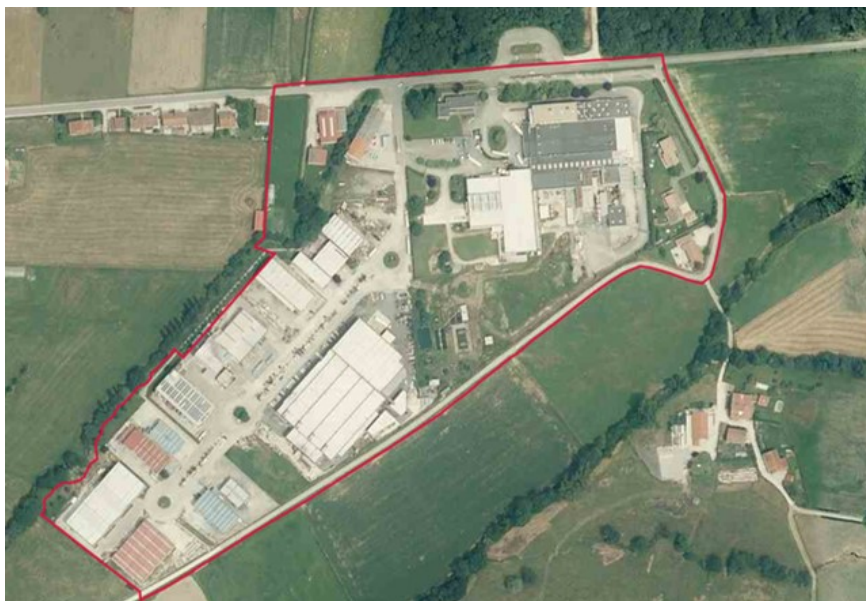
Imagen 01. Vista aérea del ámbito industrial general, con viales con solera en hormigón.
