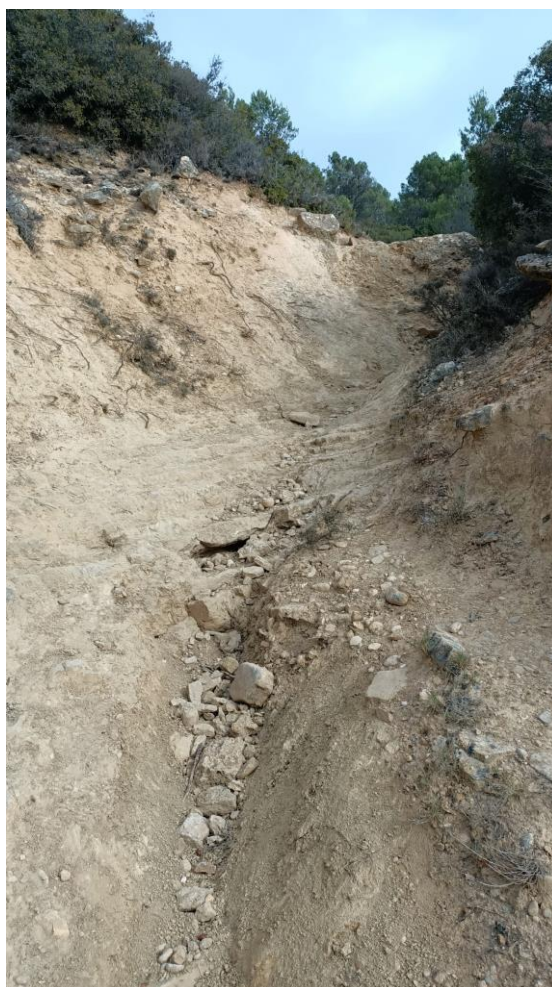
Tramo de sendero a reparar
