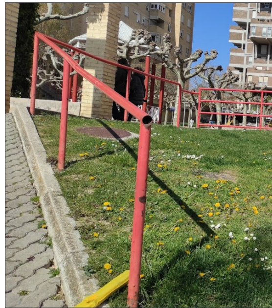
FOTO 4: Vista barandilla a desmontar
