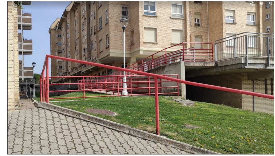
FOTO 12: Pozo de pluviales propiedad del Ayuntamiento
