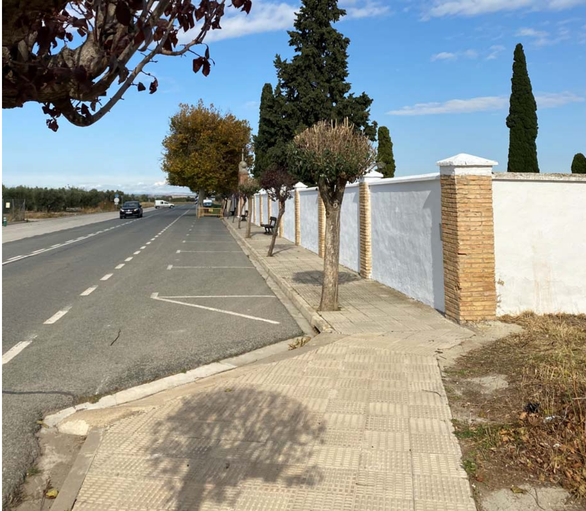
Fotografía actual estado NA-3010 junto al cementerio
