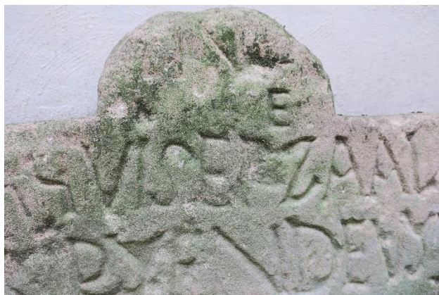
Pérdida de volumen y pátina biológica en la parte superior
