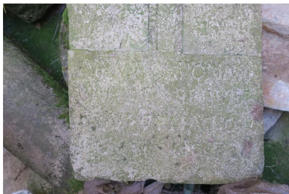
Efectos de la erosión, disolución, pérdidas de volumen y pátina biológica en la parte inferior
