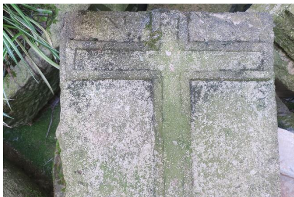
Efectos de la erosión, disolución, pérdidas de volumen, película artificial y pátina biológica en la Cruz
