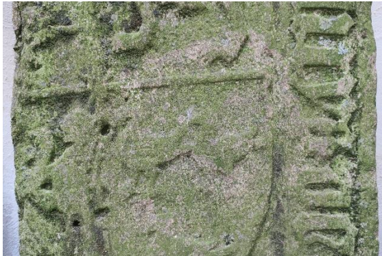
Pátina biológica, erosión, disolución. Detalle
