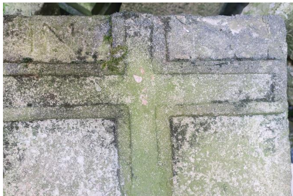
Efectos de la erosión, disolución, pérdidas de volumen, película artificial y pátina biológica en la Cruz. Detalle
