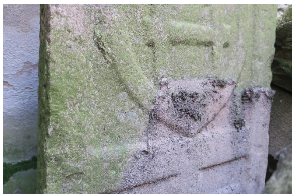
Suciedad y pátina biológica en la cara frontal
