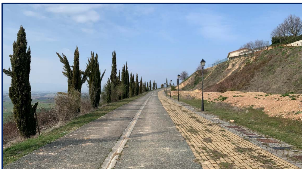
Figura nº2: Vista de la Calle San Babil correspondiente a la actuación 2
