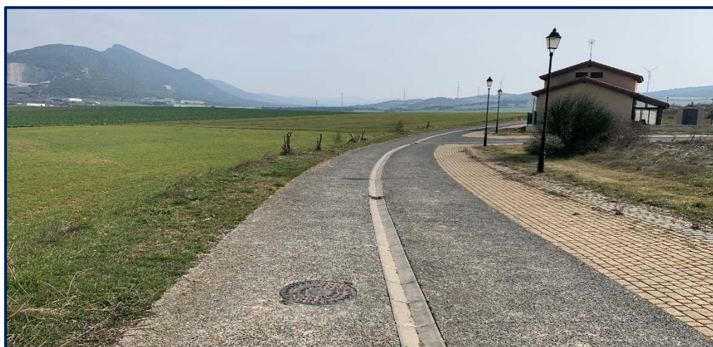
Figura nº3: Vista de la Calle San Babil correspondiente a la actuación 3
