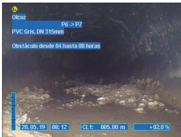
Fotografía: 4b 5m, Obstáculo desde 04 hasta 08 horas
