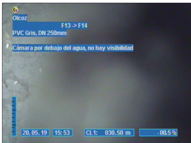
Fotografía: 202b 30,5m, Cámara por debajo del agua, no hay visibilidad
