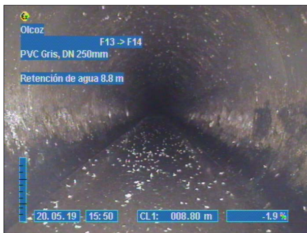
Fotografía: 201b 8,8m, Retención de agua 8.8 m
