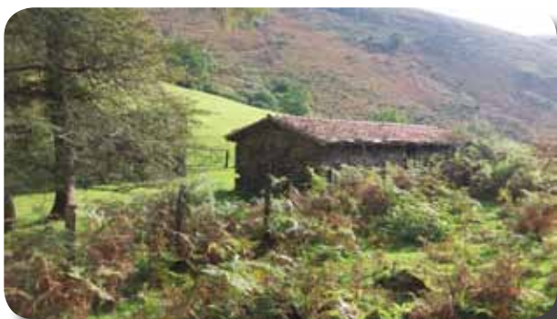
Tramo de cierre deteriorado
