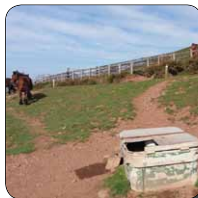
Abrevadero bajo la pista
