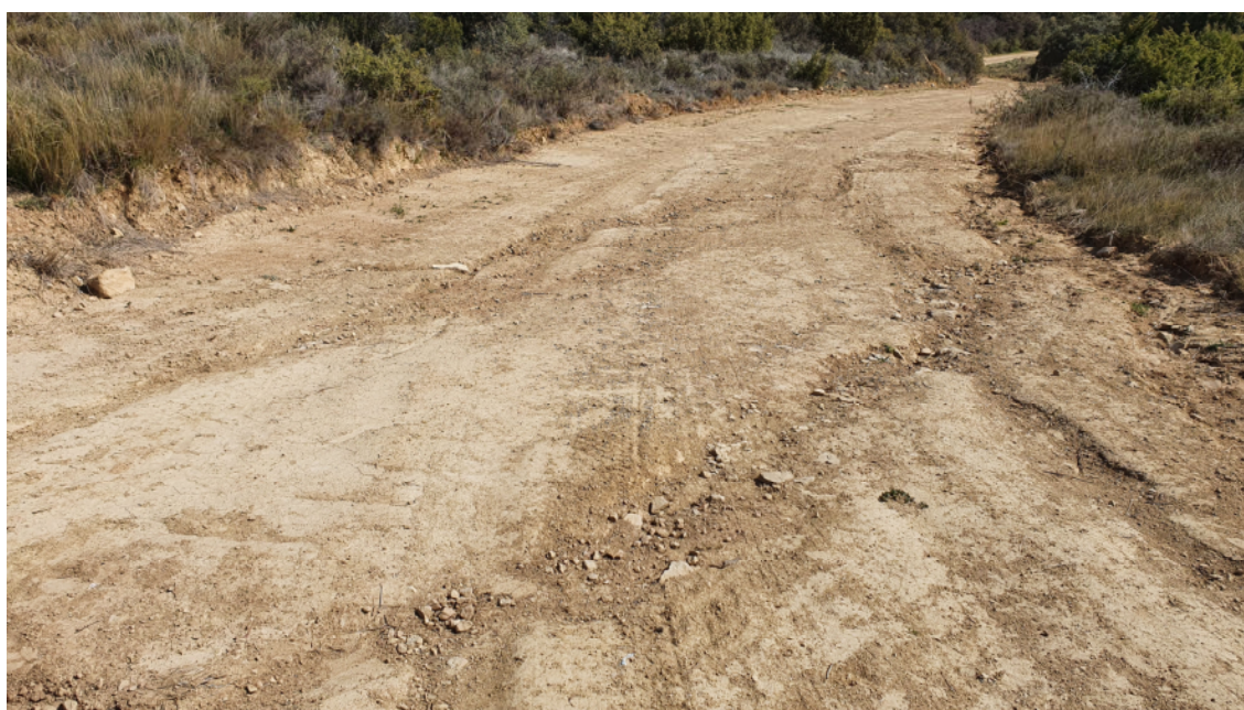
Fotografía en el camino Corral del Alto-La Revuelta de Valero
