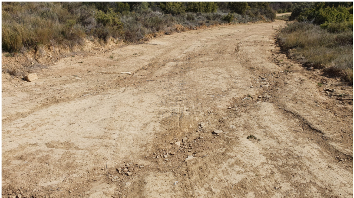
Pista de Camino Corral del Alto-La Revuelta de Valero
