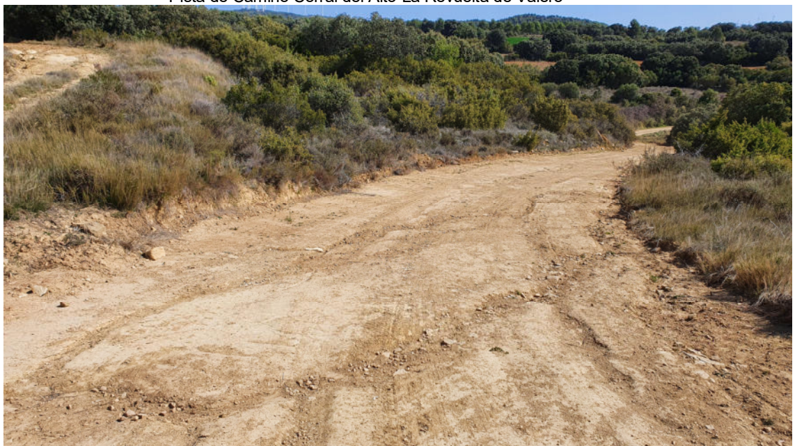
Pista de Camino Corral del Alto-La Revuelta de Valero, con firme natural de tierras, piedras y rocas
