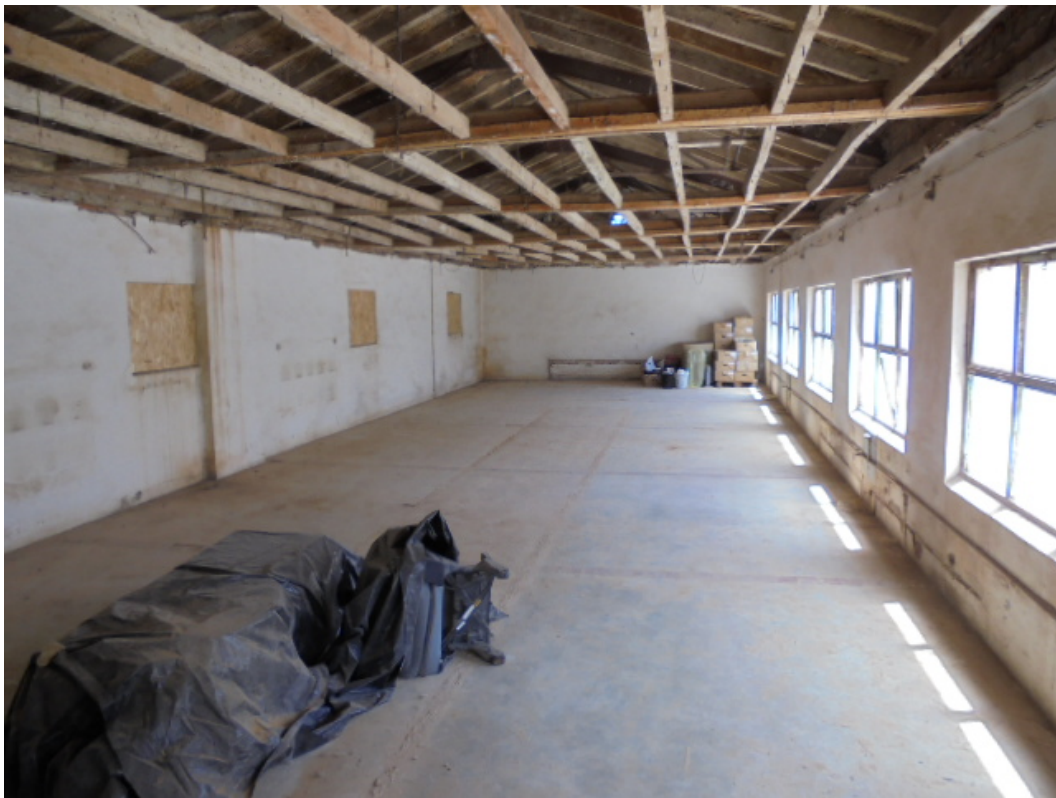
INTERIOR DE EDIFICIO – ZONA DE ACTUACIÓN
