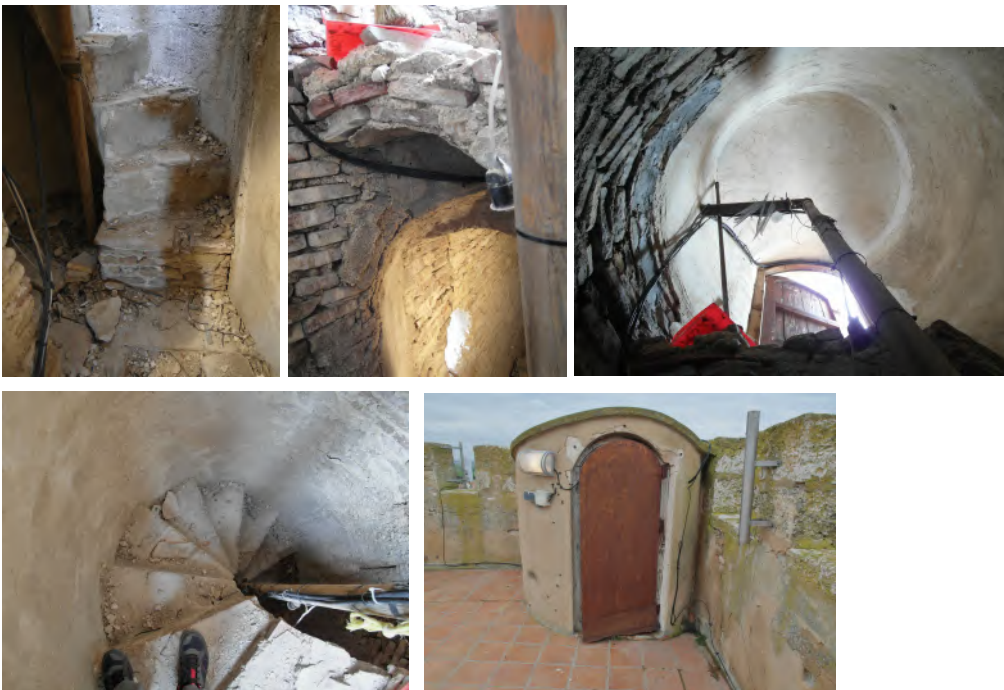
E3. ESCALERA PLANTA CUARTA-TERRAZA. Realizada con bóveda de revolución tabicada con mortero de cal y cemento.
