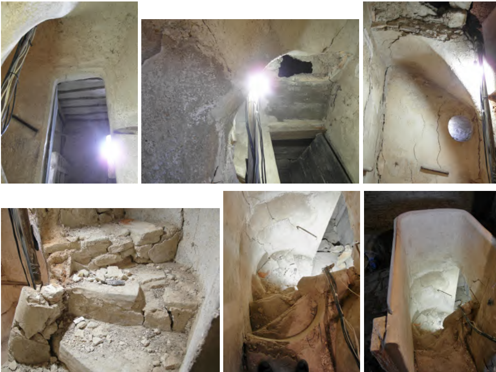
E3. ESCALERA PLANTA CUARTA-TERRAZA. Realizada con bóveda de revolución tabicada con mortero de cal y cemento.
