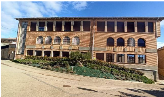
Vistas exterior e interior
