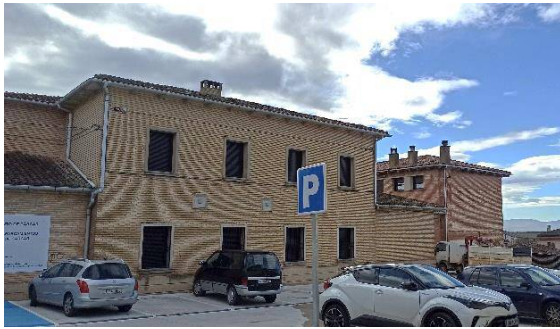
Vistas exterior e interior
