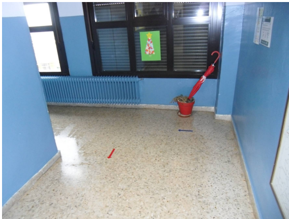
Acceso ascensor planta primera
