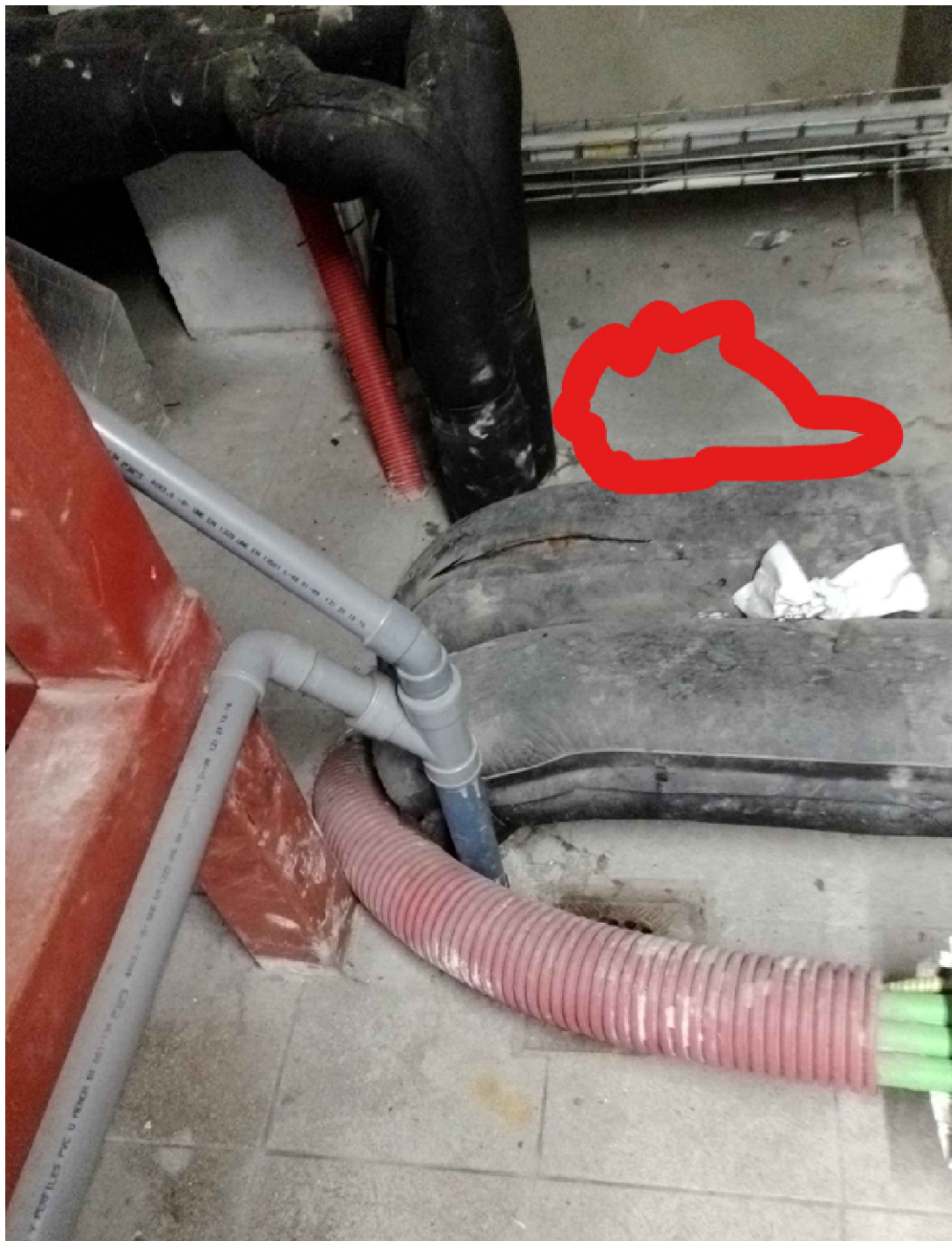
AYUDA ALBAÑILERÍA EN PLANTA SUPERIOR PARA ABRIR HUECO EN PATINILLO
