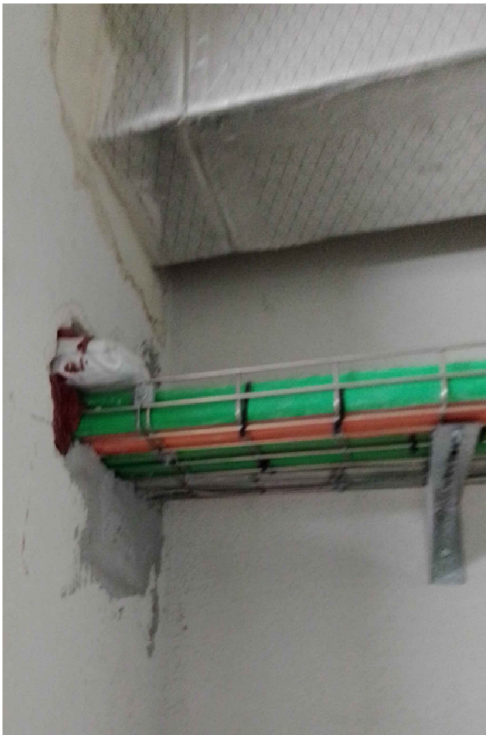
AYUDA ALBAÑILERÍA PARA PASO CONDUCTORES ALTERNA
