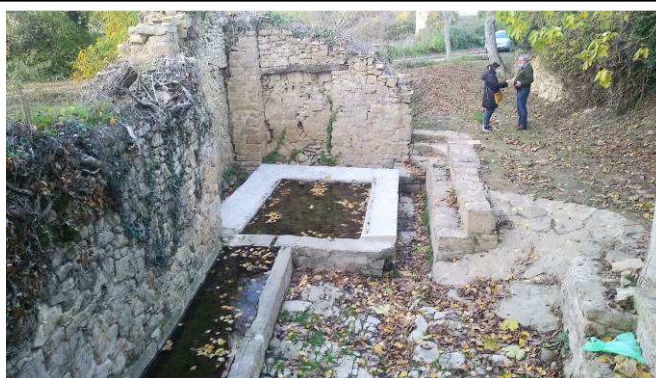
Ilustración 3: Lavadero de Muzqui sobre el que se colocará la cubierta
