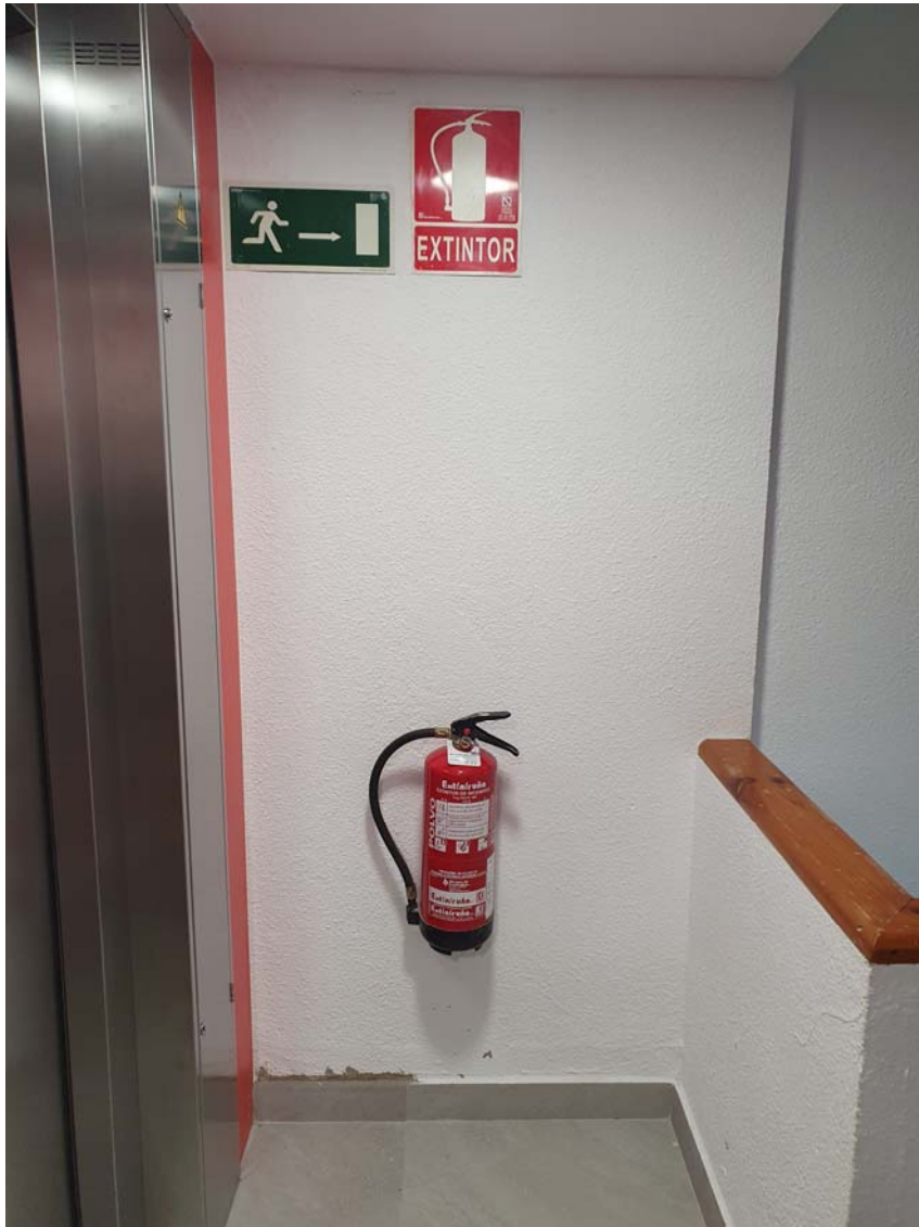
Detalle frente de ascensor en planta tercera
