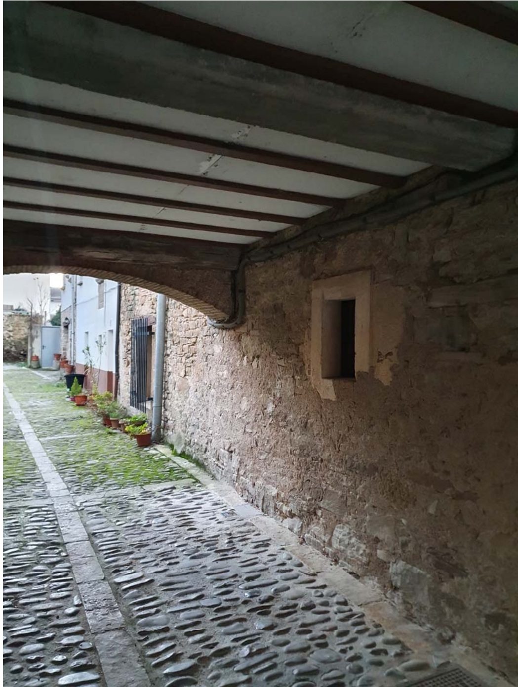
Detalle pasaje en planta baja
