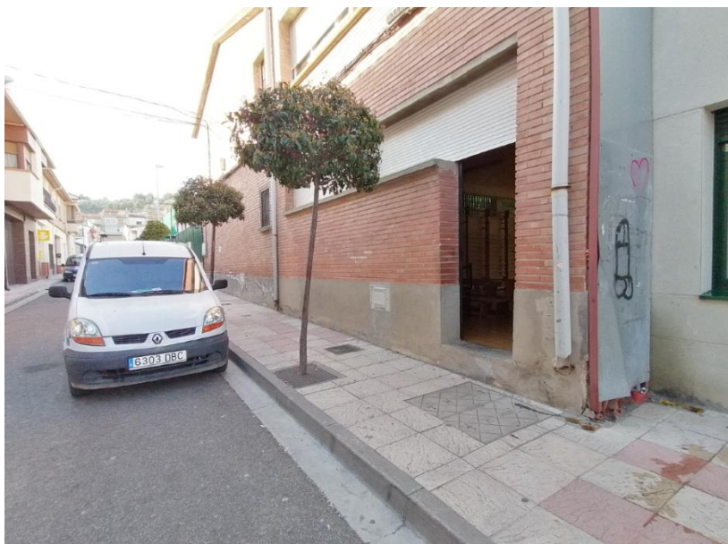
Vista exterior del actual acceso – salida desde el gimnasio del centro hacia el exterior (calle Sarasate)- Altura de salida = 45 cm
