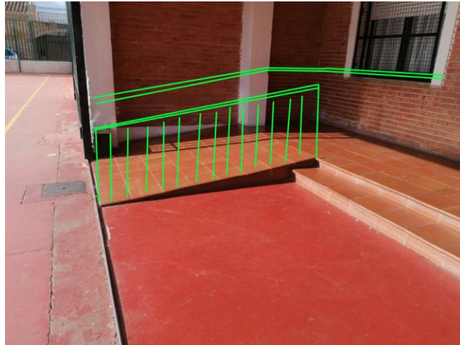
Rampa existente y croquis de barandilla y pasamanos previsto
