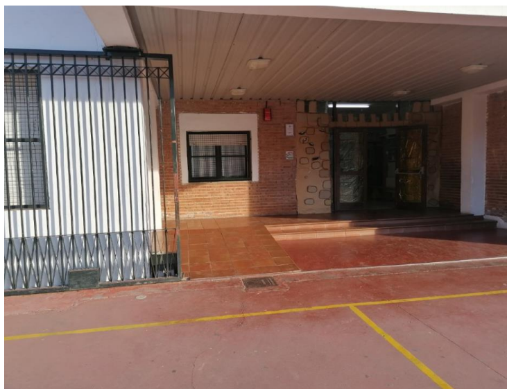
Estado actual del acceso principal
