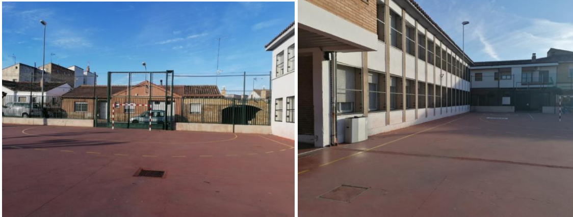
Estado actual del entorno del acceso principal y patio exterior
