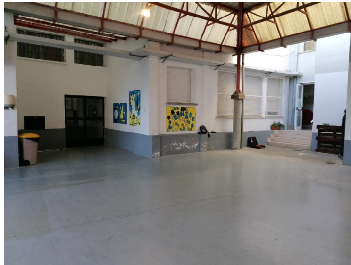
Patio interior – vista (a mano derecha) del acceso (escaleras) a planta baja del inmueble y zona lateral existente efectuada en la ampliación del centro para la instalación de ascensor. La puerta de la izquierda da acceso a la entrada principal al centro.
