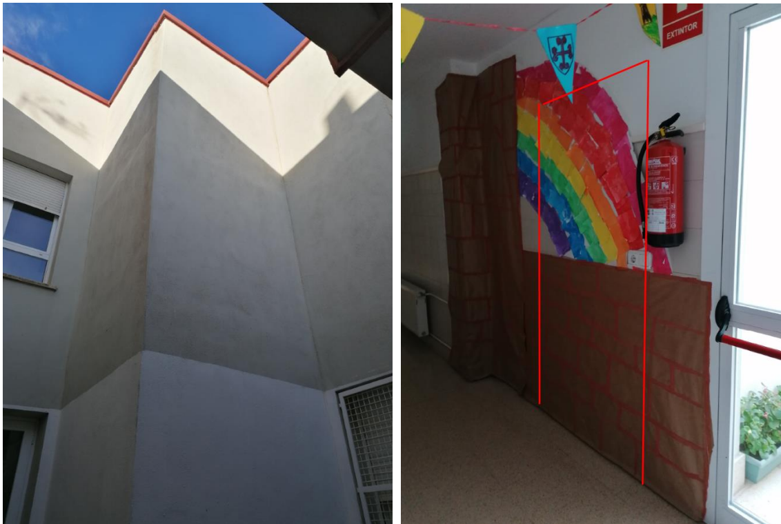
Patio interior – vista hueco existente Planta baja del edificio - Puerta futura de acceso a futuro ascensor
