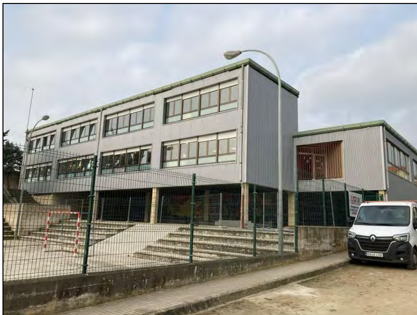
Vista de la fachada este.
