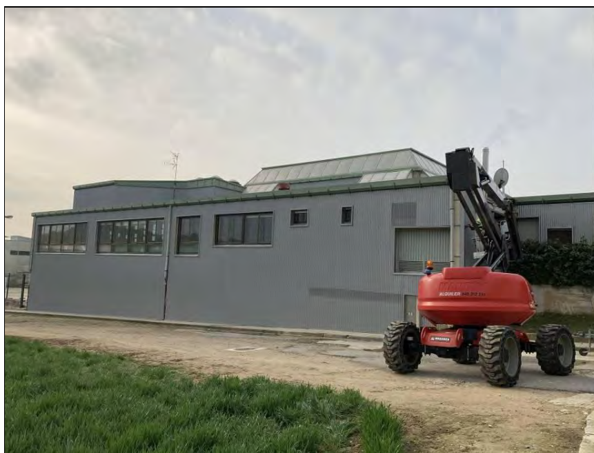
Vista de la fachada norte.
