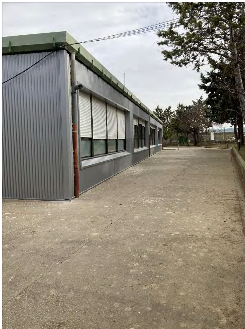
Vista de la fachada sur del colegio.
