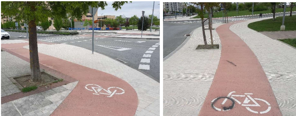
Foto 3.4 Tramo de acera bici en una rotonda de Sarriguren
