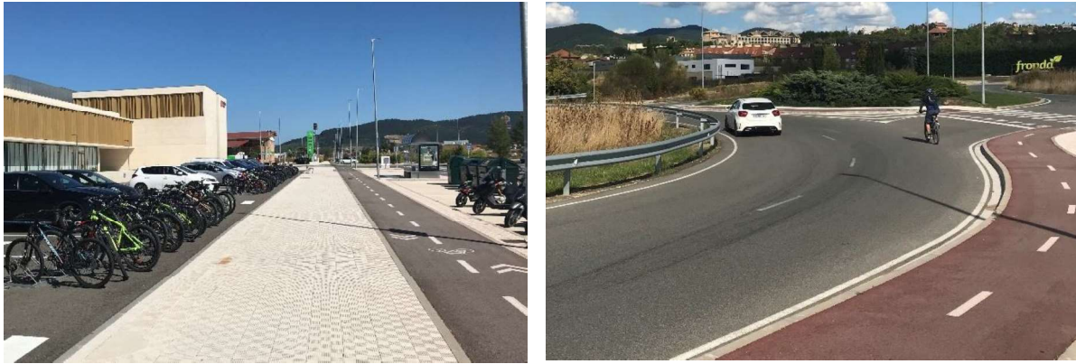
Foto 3.2 Vía ciclista en Av. Olaz junto al colegio Salesianos y justo antes del paso sobre la PA-30
