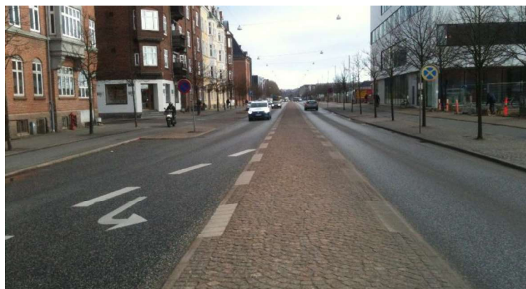
Mediana pisable para estrechar calzada (Aalborg, DK)
