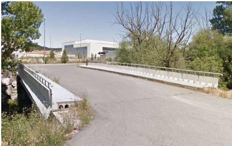
Foto 3.10 Paso sobre el río Urbi y acceso al polígono de Egüés desde la pista que viene de Gorraiz
