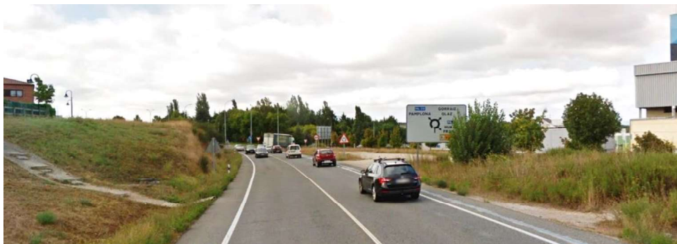
Foto 3.15 Punto de la NA-150 donde se produce el cruce de peatones sin condiciones de seguridad
