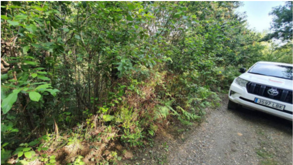
Estado del cierre de Gainekola3 a retirar
