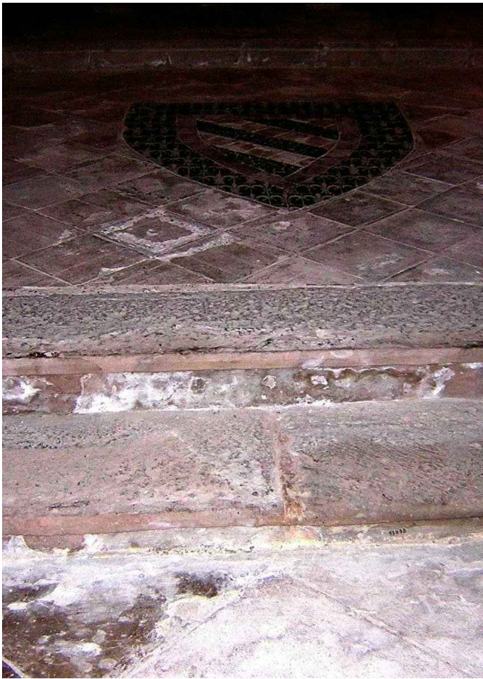
3 y 4. Sales en gradas y pavimentos de las capillas de San Roberto y San Benito
