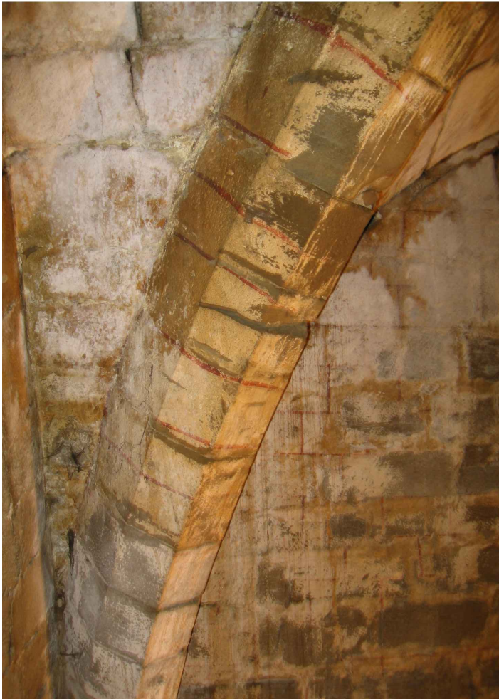
13. Bóveda con pinturas murales (despiece gótico) en último tramo de la nave central
