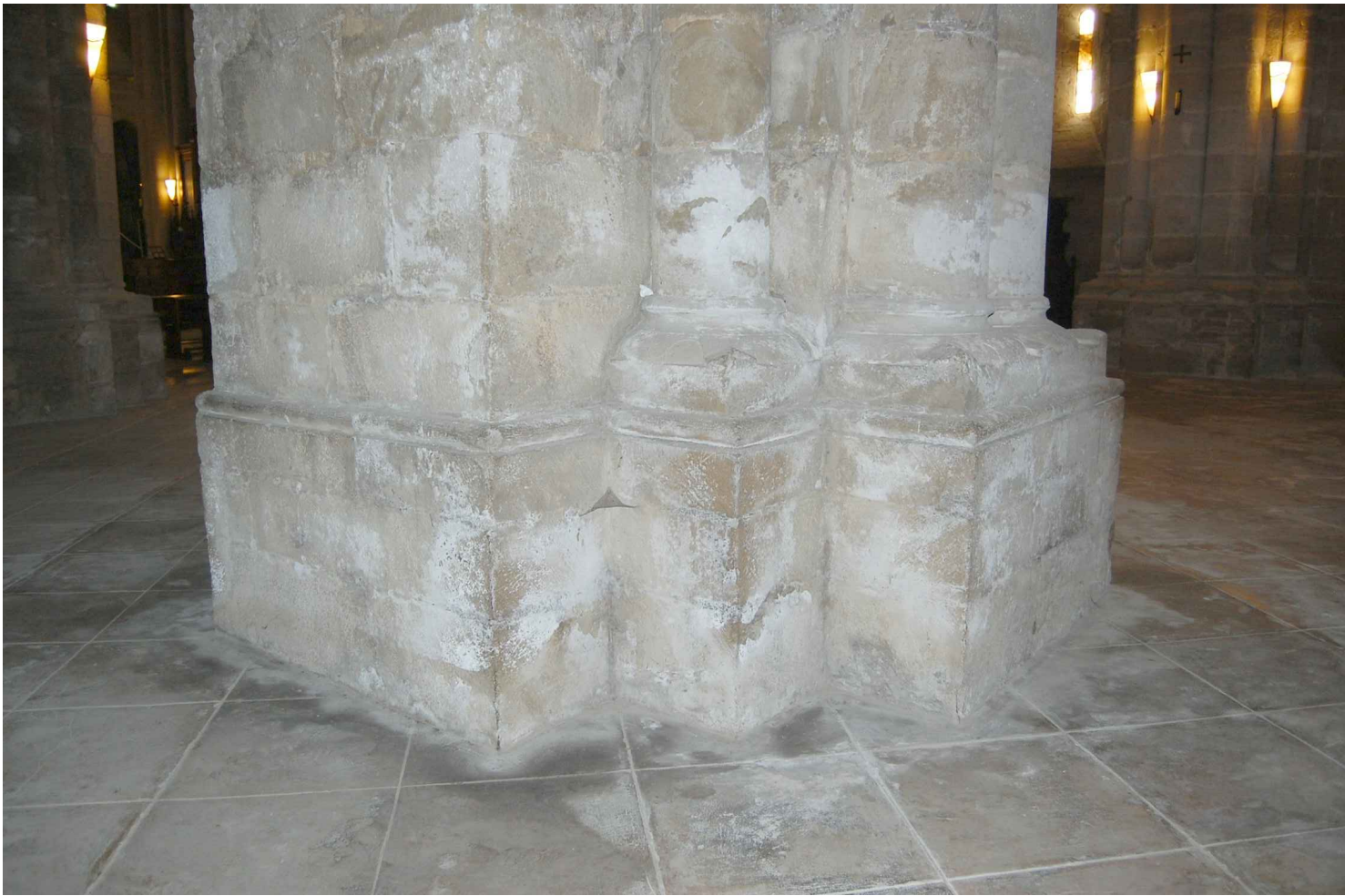
8. Pavimento de hormigón con despiece simulado y zócalo del pilar en la nave lateral norte
