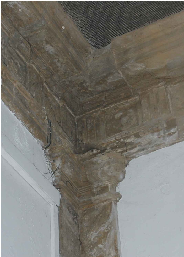
14. Pilastra y cornisa de la sacristía nueva
