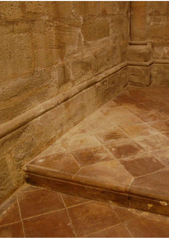
3 y 4. Sales en gradas y pavimentos de las capillas de San Roberto y San Benito
