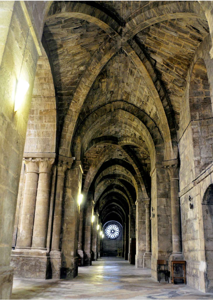
12. Bóvedas de la nave lateral norte
