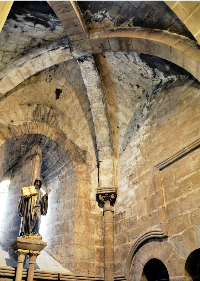
9 y 10. Costra cálcica carbonatada en bóvedas de las capillas de San Bernardo y San Roberto
