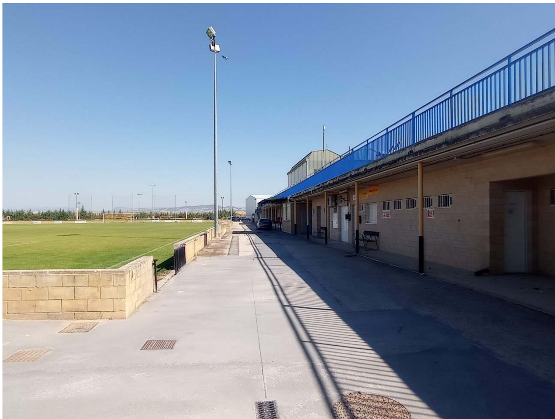
Vestuario e instalaciones del futbol
