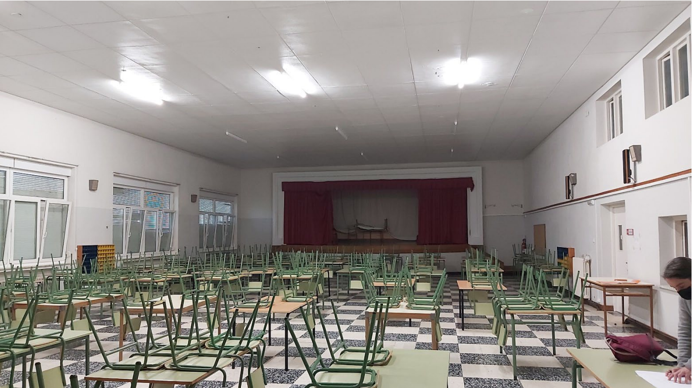
Estado actual comedor escolar, adaptado en el antiguo salón de actos, sin remodelar.
